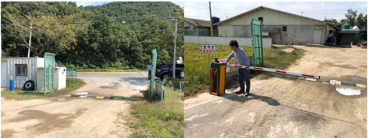
그림 92. 축사 개폐장치의 설치 및 작동 확인
