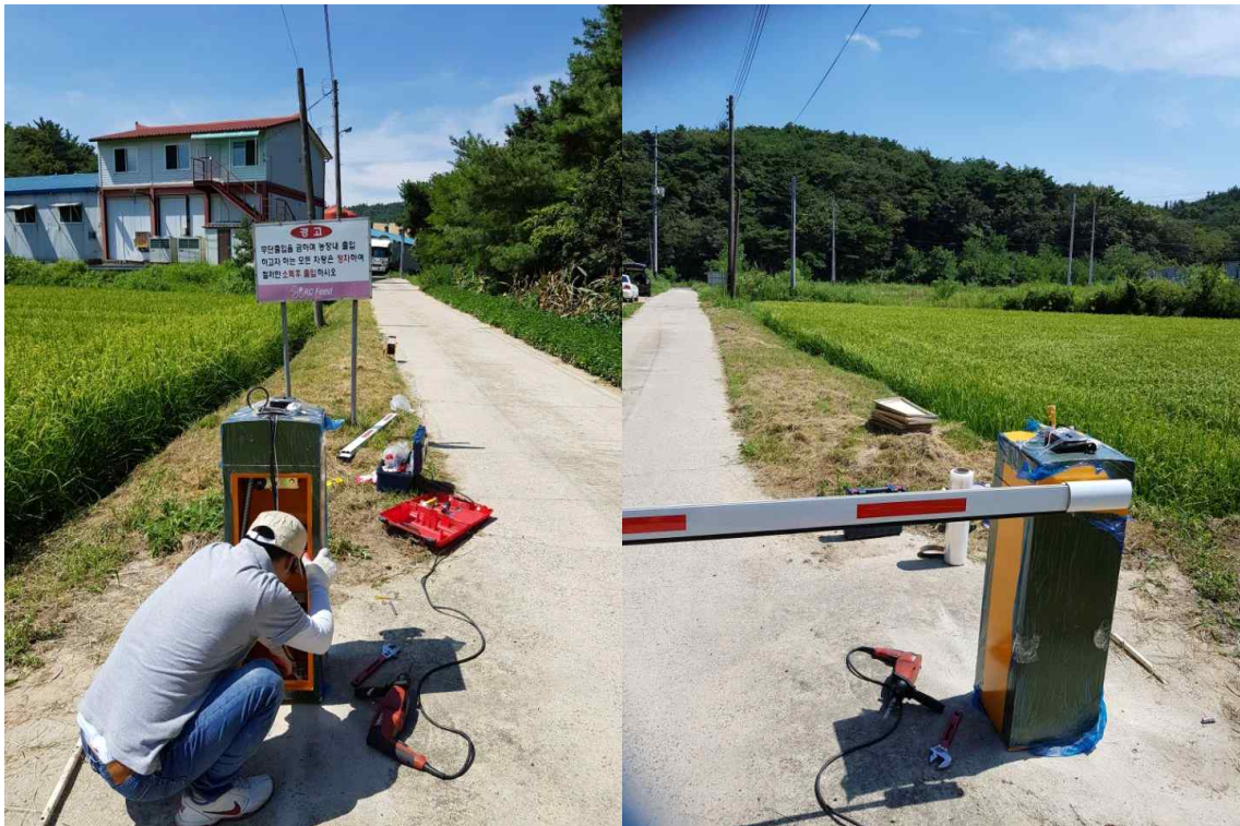
그림 90. 축사의 출입구 차량 출입 개폐기 설치공사
