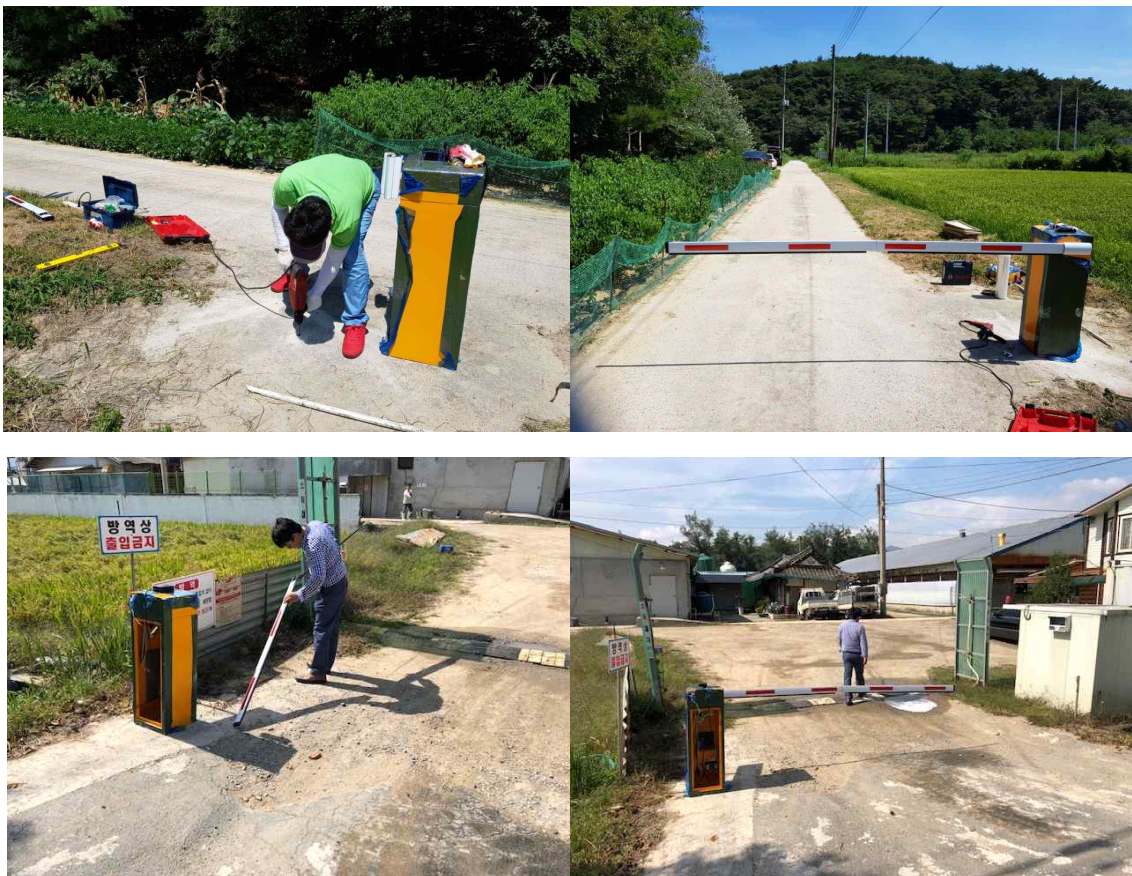
그림 88. 차량용 개폐장치의 현장 설치(경주 한진농장[그림 위], 고령 흥익농장[그림 아래])
