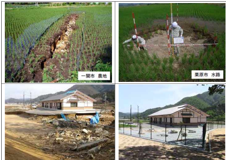
그림 2.5 지진으로 인한 양배수장 주변의 재해 형태
