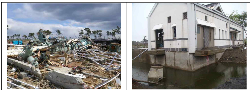
그림 2.7 지진해일(쓰나미)로 인한 배수장의 붕괴 및 취락 배수시설의 파손
