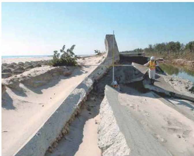
그림 2.6 제방 뒤 사면 피복공 피해 (요시다 해안)
