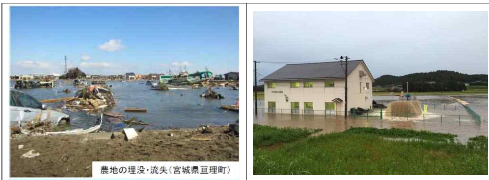
그림 2.8 지진해일(쓰나미)로 인한 배수장 및 주변 농경지의 침수
