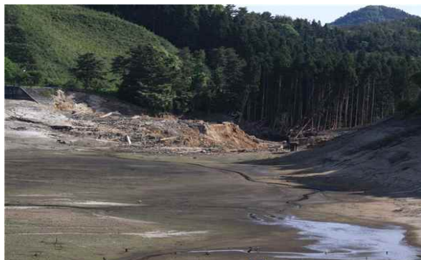
<그림 1-1> 동일본 지진에 의한 후지누마 저수지의 붕괴(2011)
