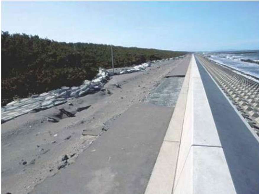
그림 2-3 제방 뒷사면 피복공의 유실 (一川目 지구 해안)
