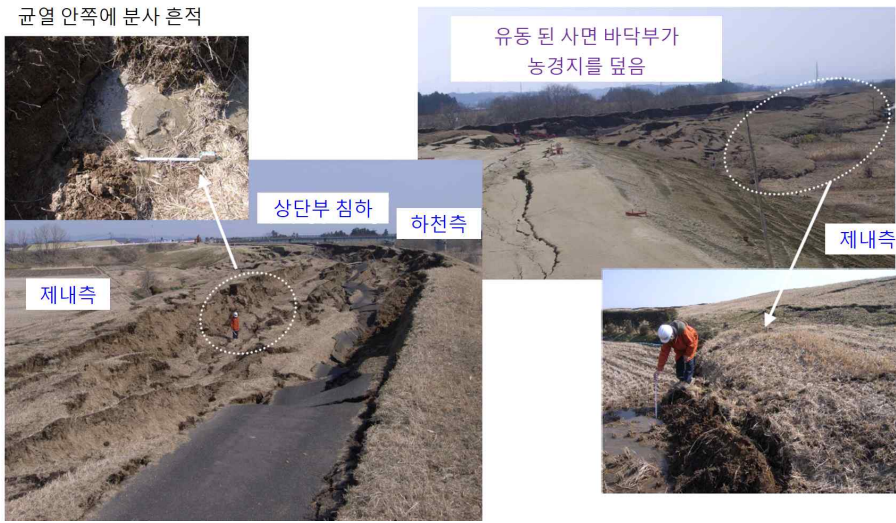
그림 2.8 사면 바닥부 축방 유동 형
