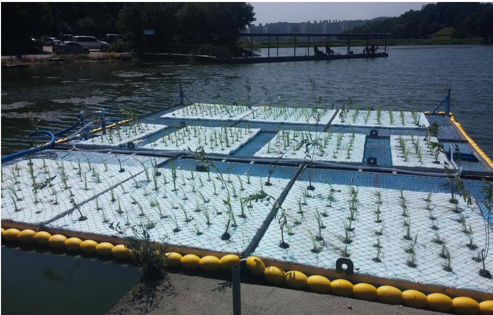
<그림 4-36> 생태융합형 집축산화부도 설치 전경
