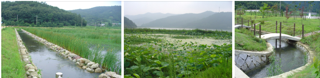
<그림 3-3> 지표흐름 인공습지 설치 사례(전남 감둔저수지)
