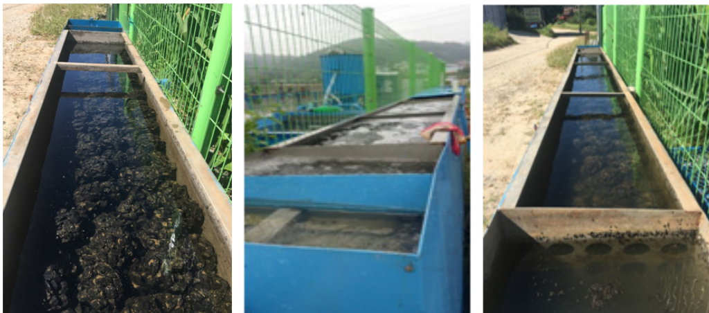
<그림 4-47> 바이오스톤 접촉산화시스템 플랜트 설치 전경
