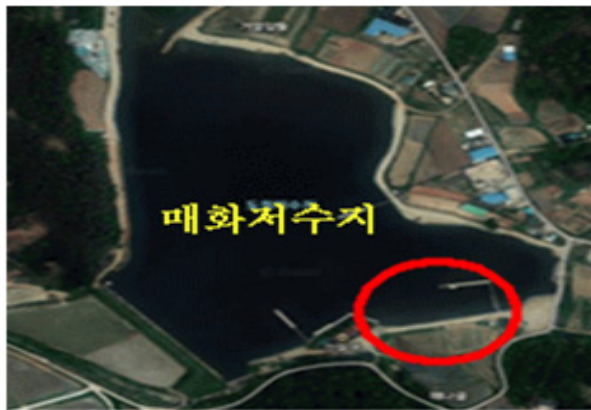
<그림 4-46> 바이오스톤 접촉산화시스템 플랜트 설치 지구
