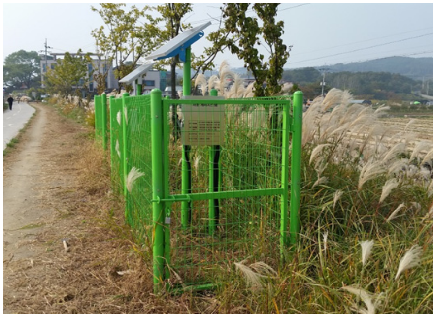
<그림 4-19> 문산제 계측기 제외 설치 현장
