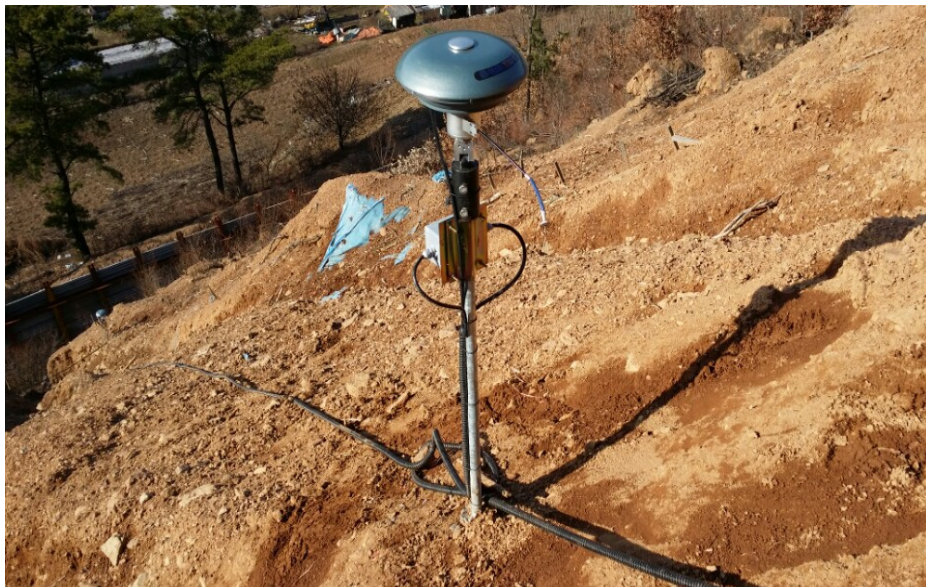
<그림 4-8> 지표변위계 계측센서 설치
