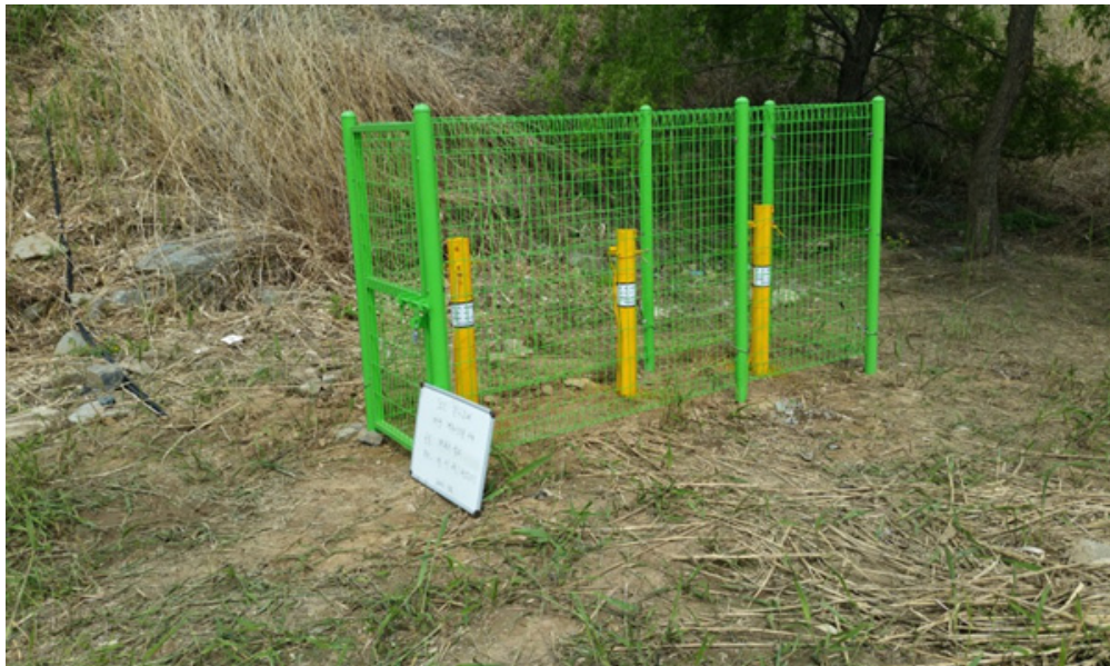
<그림 4-24> 문산제 계측기 제외지 설치 현장 (신동훈, 2016)
