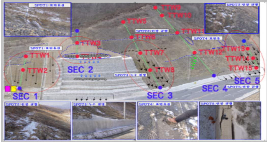
〈그림 5-16〉 2006년 GMG 강릉시 OO면 사면 계측기 설치 현황 (국민안전처, 2015)
