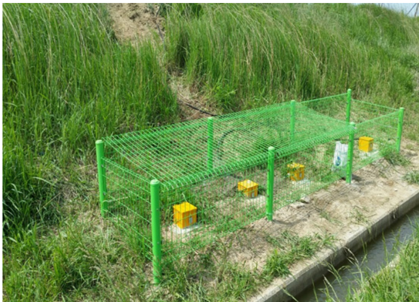
<그림 4-21> 문산제 계측기 제내 설치 현장 (신동훈, 2016)
