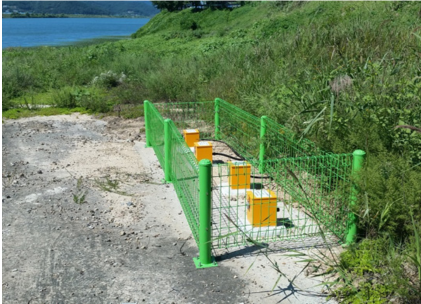
<그림 4-20> 문산제 계측기 제방마루 설치 현장 (신동훈, 2016)
