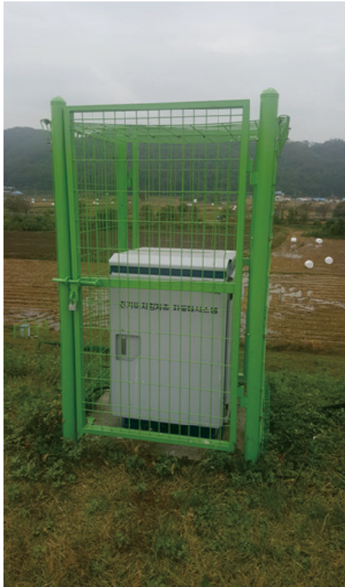
<그림 4-13>이동저수지 전기비저항 탐사 계측기 설치 현황
