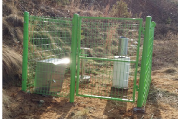
<그림 4-6> 강수량계 계측센서 설치
