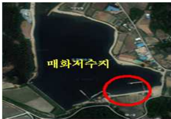
<그림 3-33> 바이오스톤 접촉산화시스템 플랜트 설치 지구
