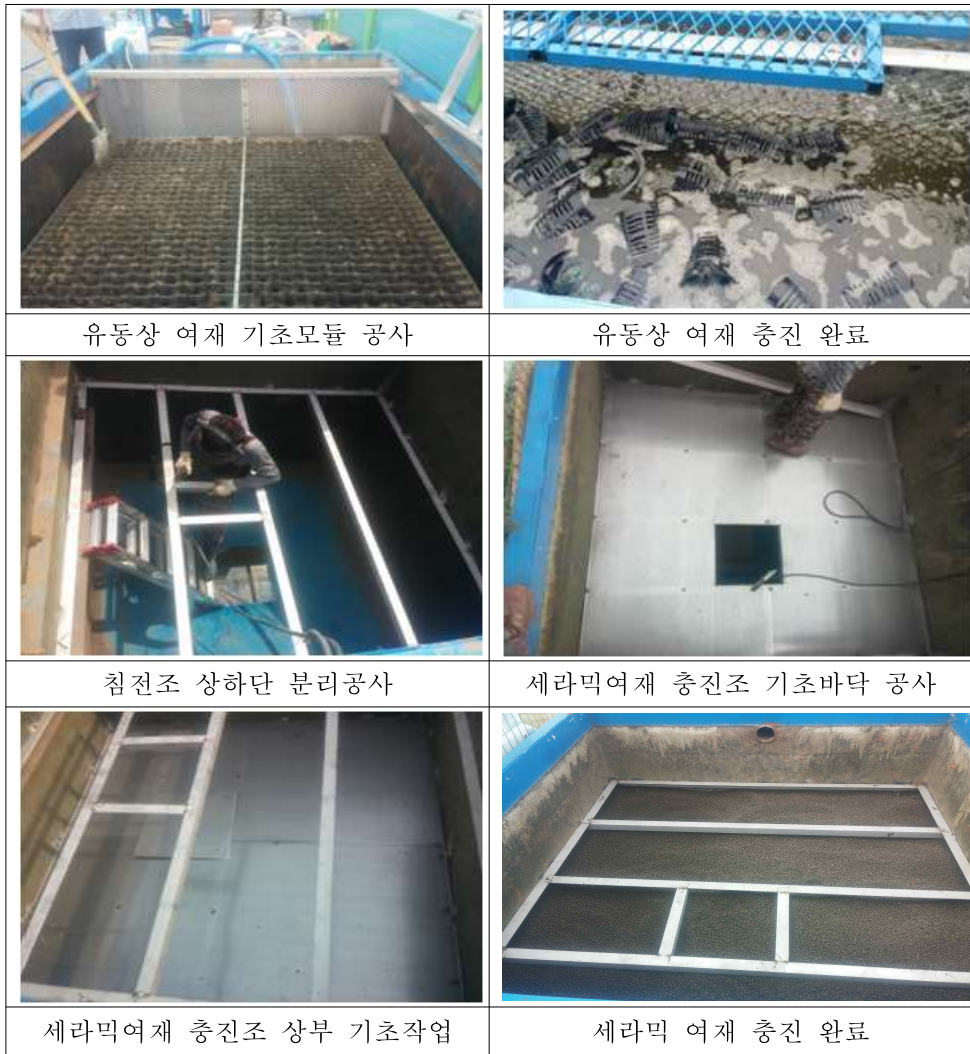
<그림 3-14> 전처리 공정 및 후처리 공정 보완공사 사진대지
