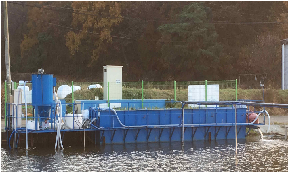
<그림 3-4> 생태융합형 집축산화수로 설치 전경
