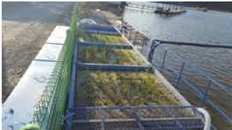
<그림 3-16> 식생매트 부착 후 접촉산화시스템 전경
