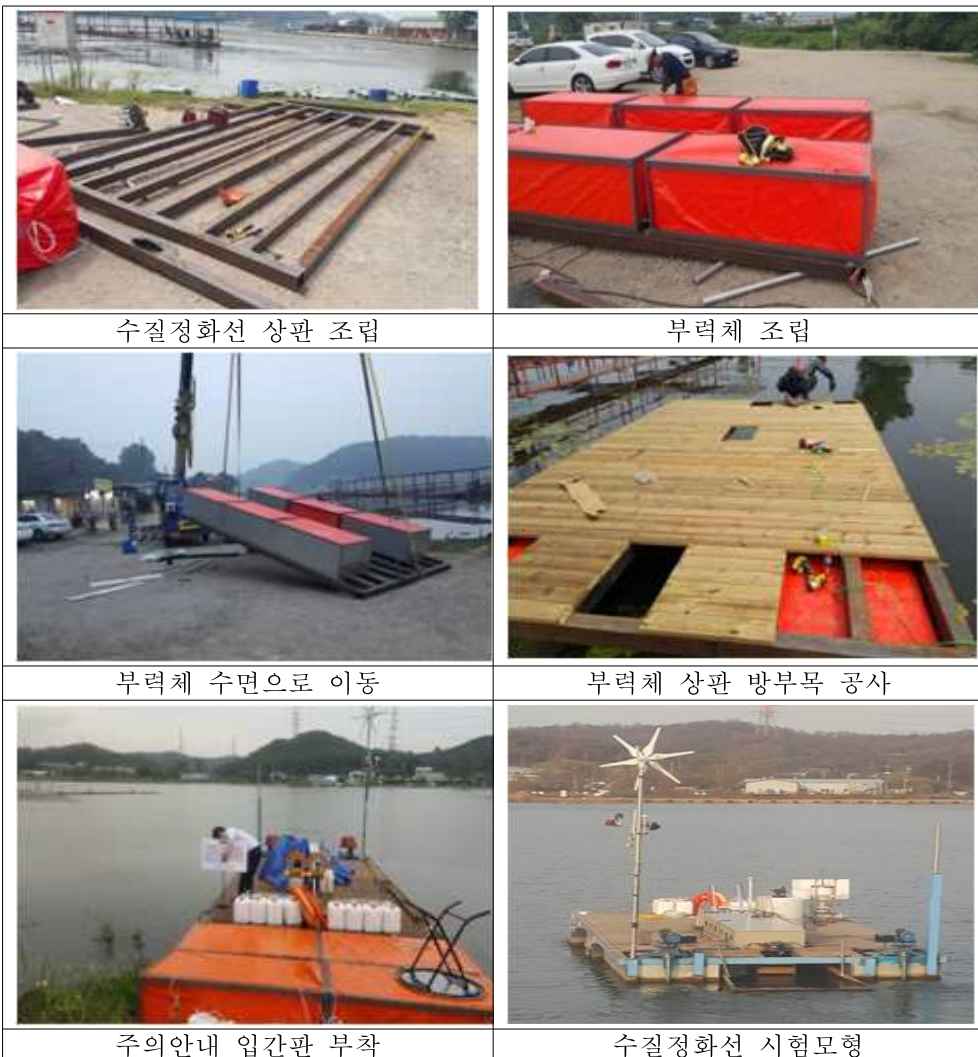
<그림 5-3> 무인항법 이동식 수질정화선 시험모형 제작과정
