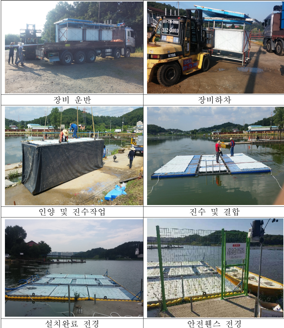
<그림 4.1-20> 접촉산화부도 제품 운반 및 설치 전경
