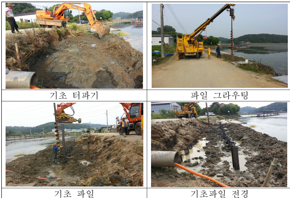
<그림 4.1-12> 생태융합형 접촉산화수로 설치 기초공사
