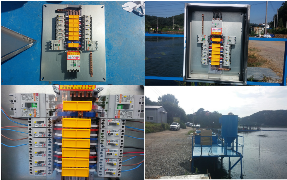
<그림 4.1-14> 전기 판넬 설치 공사
