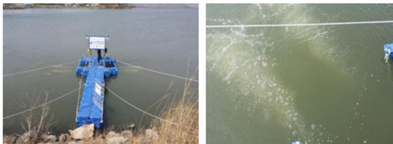
<그림 4.2-3> 대산저수지 마이크로버블 설치 및 버블 전경
