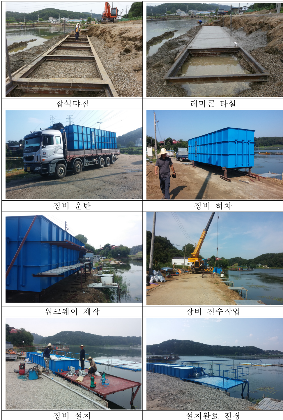
<그림 4.1-13> 접촉산화수로 설치 기초공사 및 제품 진수
