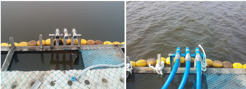
<그림 4.1-26> 처리수 배출을 위한 수중펌프 설치
