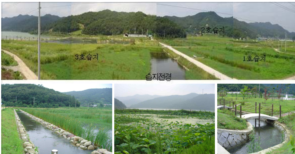
<그림 4.3-23> 지표흐름 인공습지 설치 사례(전남 감돈저수지)
