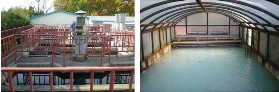
<그림 4.3-8> 일산호수공원의 가압부상장치(지상)
