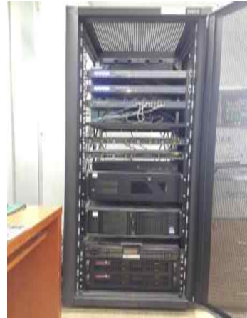
그림 3-2-41. 청원생명쌀조합공동사업법인RPC에 설치된 u-IT기반 광역통합관리시스템의 Web/DB server rack
