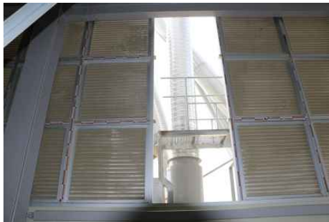
그림 2-2-1-27. 경북 예천소재RPC에 설치된 실내설치형 통합집진기의 배출부 갠리리창
