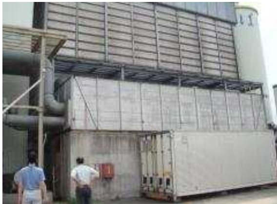
그림 2-2-1-5. 일본 CE에 설치된 세정식집진시스템(김 등, 2013)
