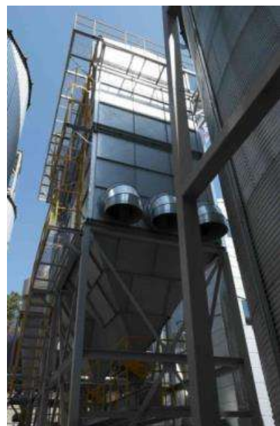
그림 2-2-1-3. 한국식품연구원(2013)에서 개발한 통합집진기 개념도 및 RPC에 설치된 통합집진기
