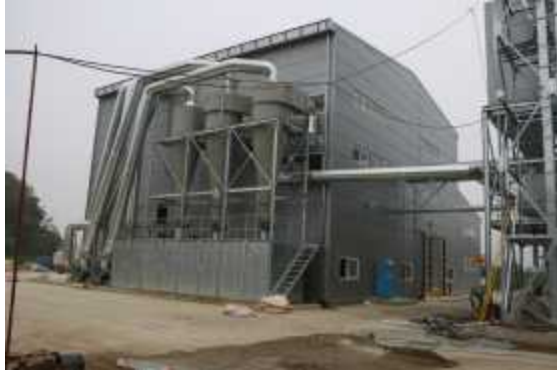
그림 2-2-1-23. 실내설치형 통합집진기가 설치된 경북 예천소재 RPC 건조저장시설
