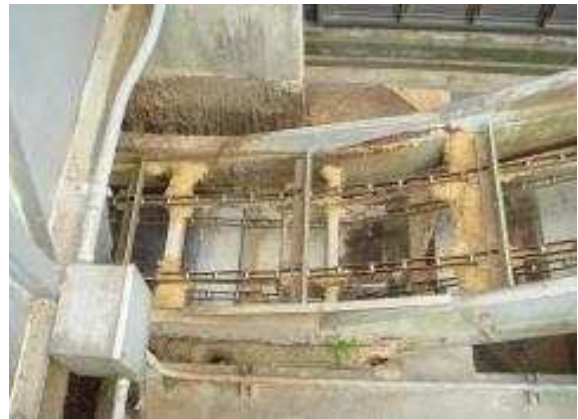
그림 2-2-1-5. 일본 CE에 설치된 세정식집진시스템(김 등, 2013)
