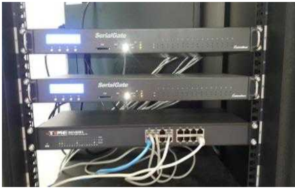
그림 3-2-41. 청원생명쌀조합공동사업법인RPC에 설치된 u-IT기반 광역통합관리시스템의 Web/DB server rack
