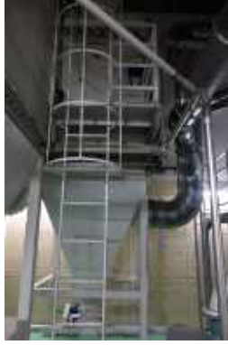
그림 2-2-1-7. 일본 정미공장에 설치된 백필터와 집진실 단열 모습
