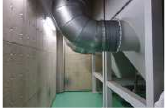
그림 2-2-1-7. 일본 정미공장에 설치된 백필터와 집진실 단열 모습
