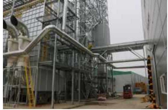
그림 2-2-1-23. 실내설치형 통합집진기가 설치된 경북 예천소재 RPC 건조저장시설
