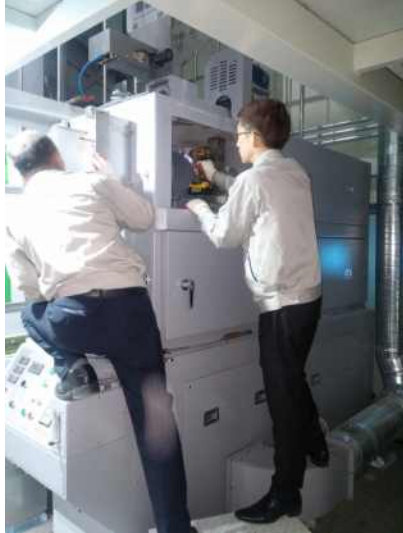
(클린라이스 대량제조시스템 주요부품 설치 장면)
