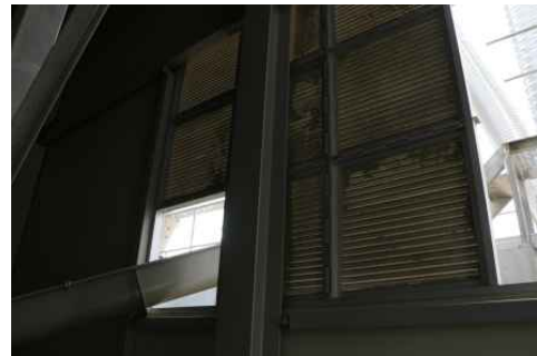
그림 2-2-1-27. 경북 예천소재RPC에 설치된 실내설치형 통합집진기의 배출부 갠리리창
