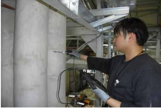
(여과포 통과속도 측정)
