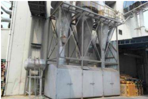
(Rotary valve가 누락된 사이클론)
