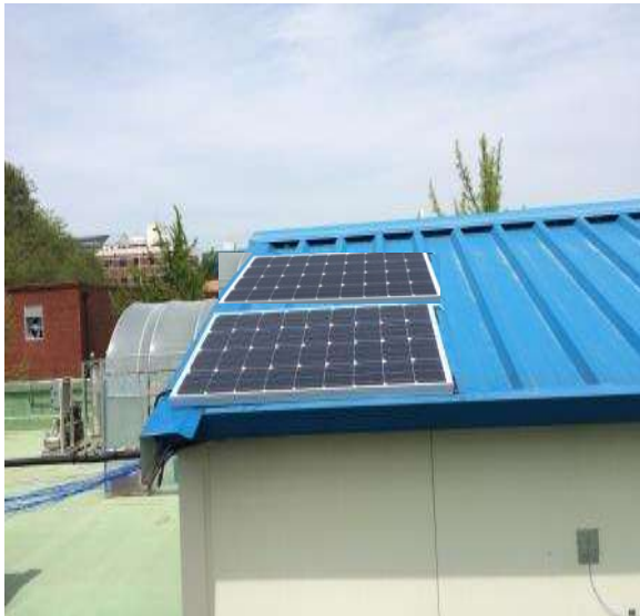
[그림] 모형돈사에 태양광 패널 추가 부착
