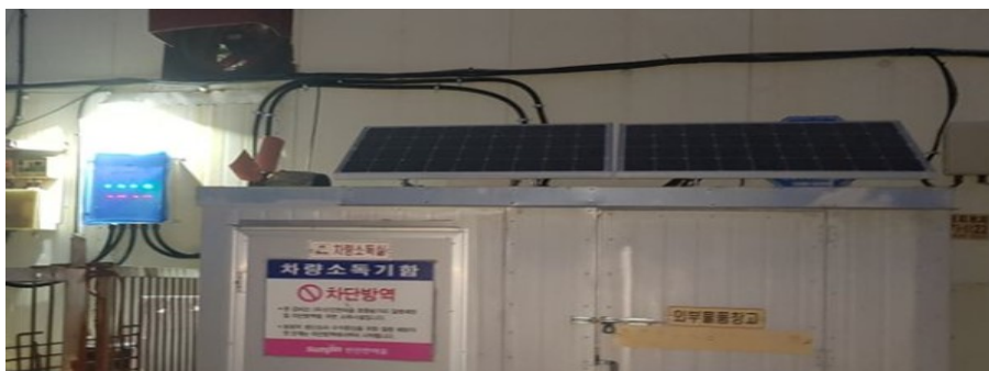
[그림] 태양광 패널 설치모습
