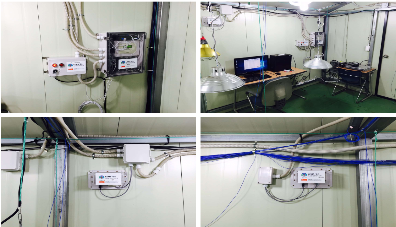
[그림] 실험돈사 내 설치된 축사환경 진단 시스템(LEMS) 및 온·습도, CO 2 , 연기 감지 센서
