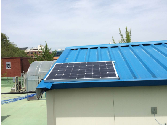
[그림] 10 모형돈사에 태양광 패널 부착 사진.
