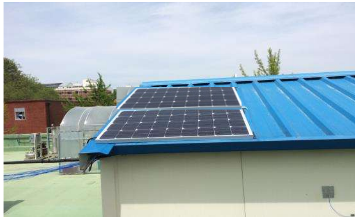
[그림] 모형돈사에 태양광 패널 부착 사진
