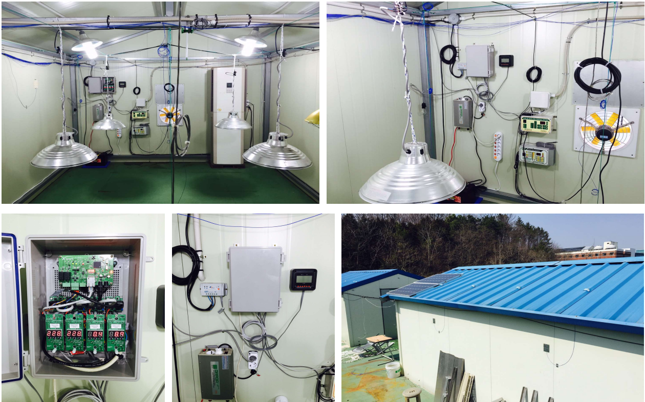
[그림] 실험돈사 내 설치된 전력 계측 시스템(Farmnote)
