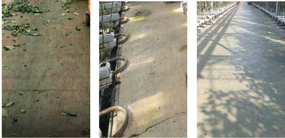
그림 44 온실별 노면 상태(좌:표면이 고르지 못함, 중: 표면이 고른 편이나 중간에 금이 가거나 턱이 있는 부분 존재, 우: 표면이 고름)
