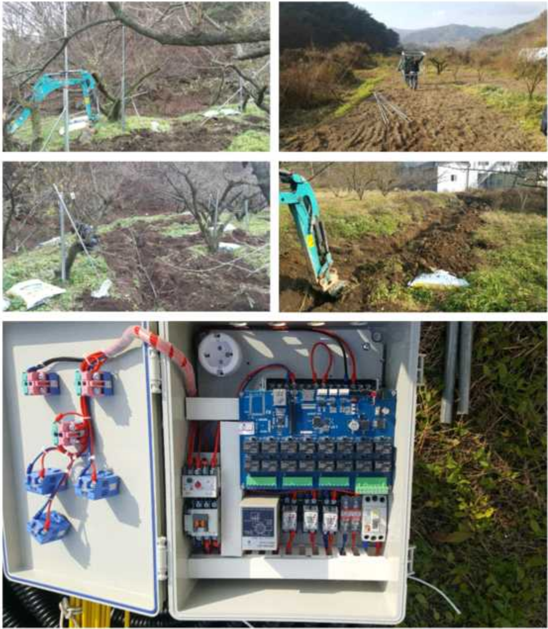
그림158. 서리에방을 스프링클러 설치
