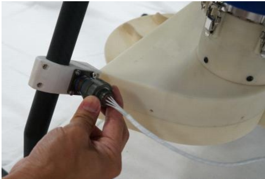
그림 97. 전원 공급과 제어를 위한 배선 작업
