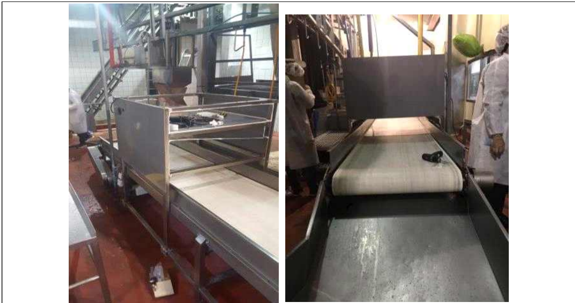
(그림) 설치 위치 및 설치중 영상
