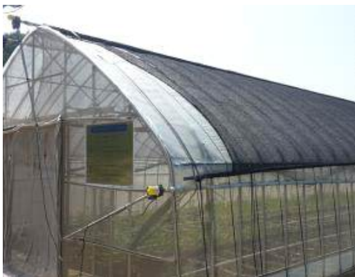
2중 차광망 설치
