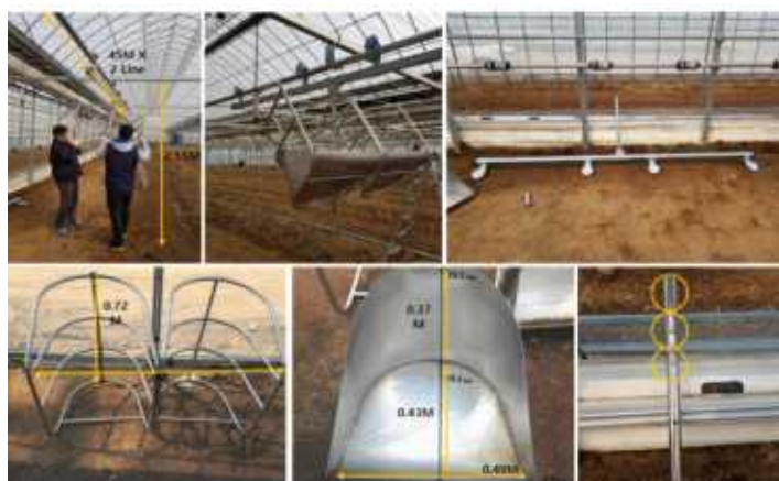
그림 4-52. 절화 백합 습식유통 레일시스템 설치
