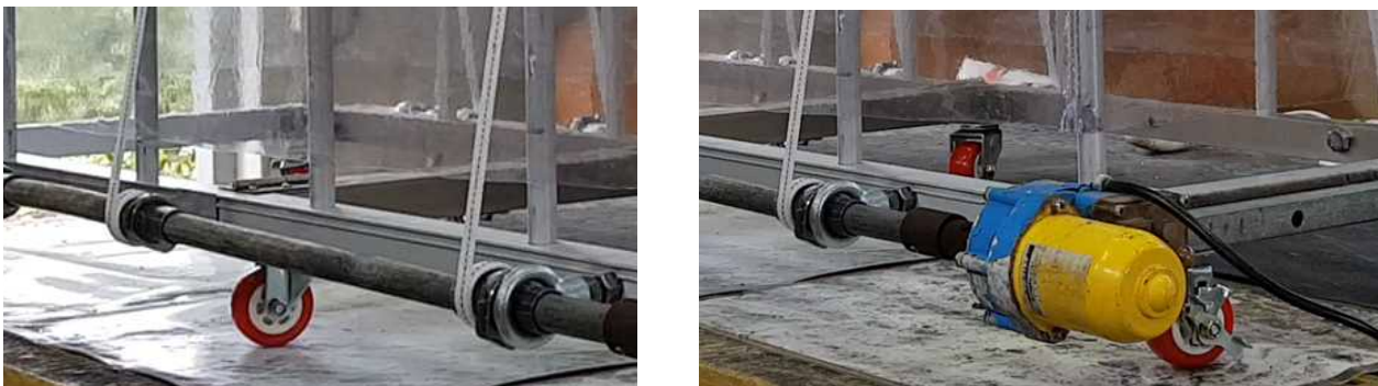
<그림> 파이프의 체결 사진
