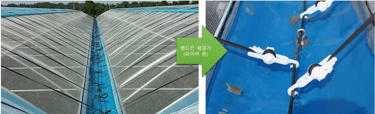
<그림> 체결기 현장 설치
