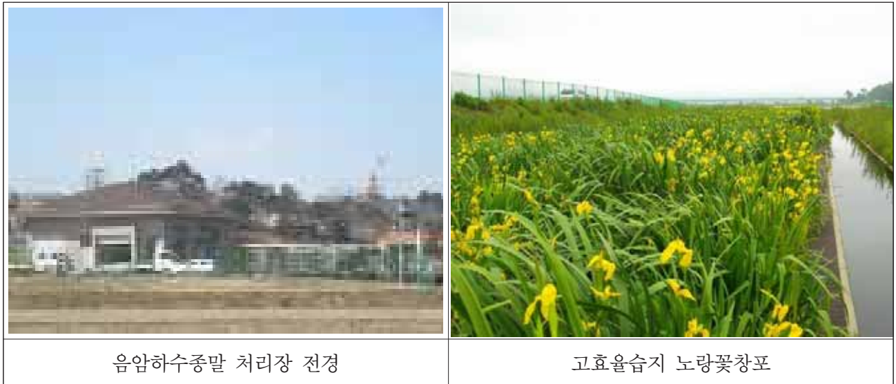
[그림 10-1-9] 하수종말처리장 전경 및 고효율습지 노랑꽃창포 현황
