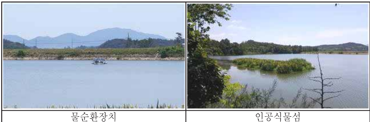
[그림 15-1-5] 기타 수질개선시설 현황
