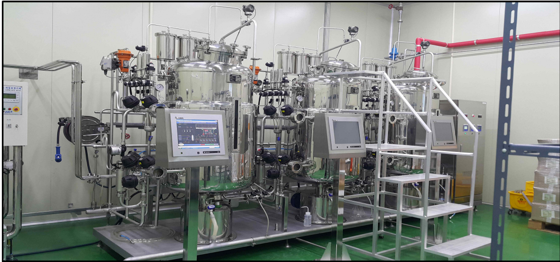
그림 58. Pilot plant 발효조
