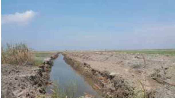
(a) 배수로 공사
