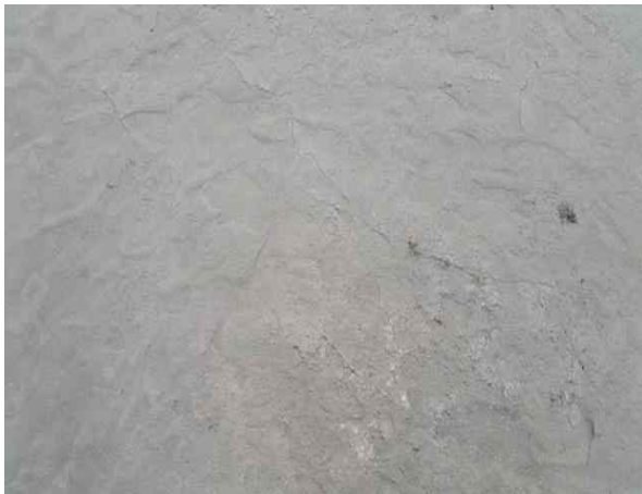
(c) 토양 균열
