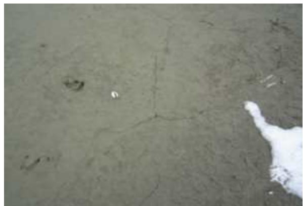
(f) 토양 균열
