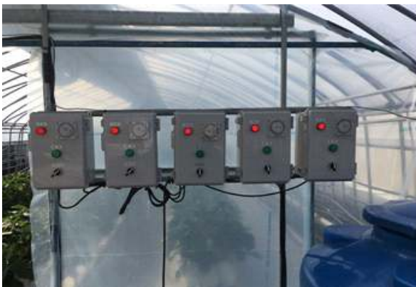
[그림54] 양액공급 제어 시스템
