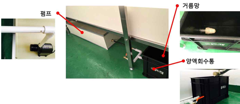
그림 3-3-19. 배액 수거 시스템(양액여과 및 재순환)
