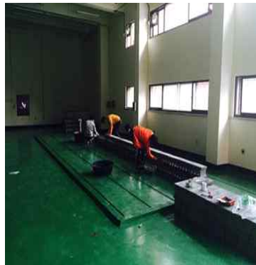
<그림1.4> 시멘트 블록을 이용하여 Soil-bin 지지대 제작.
