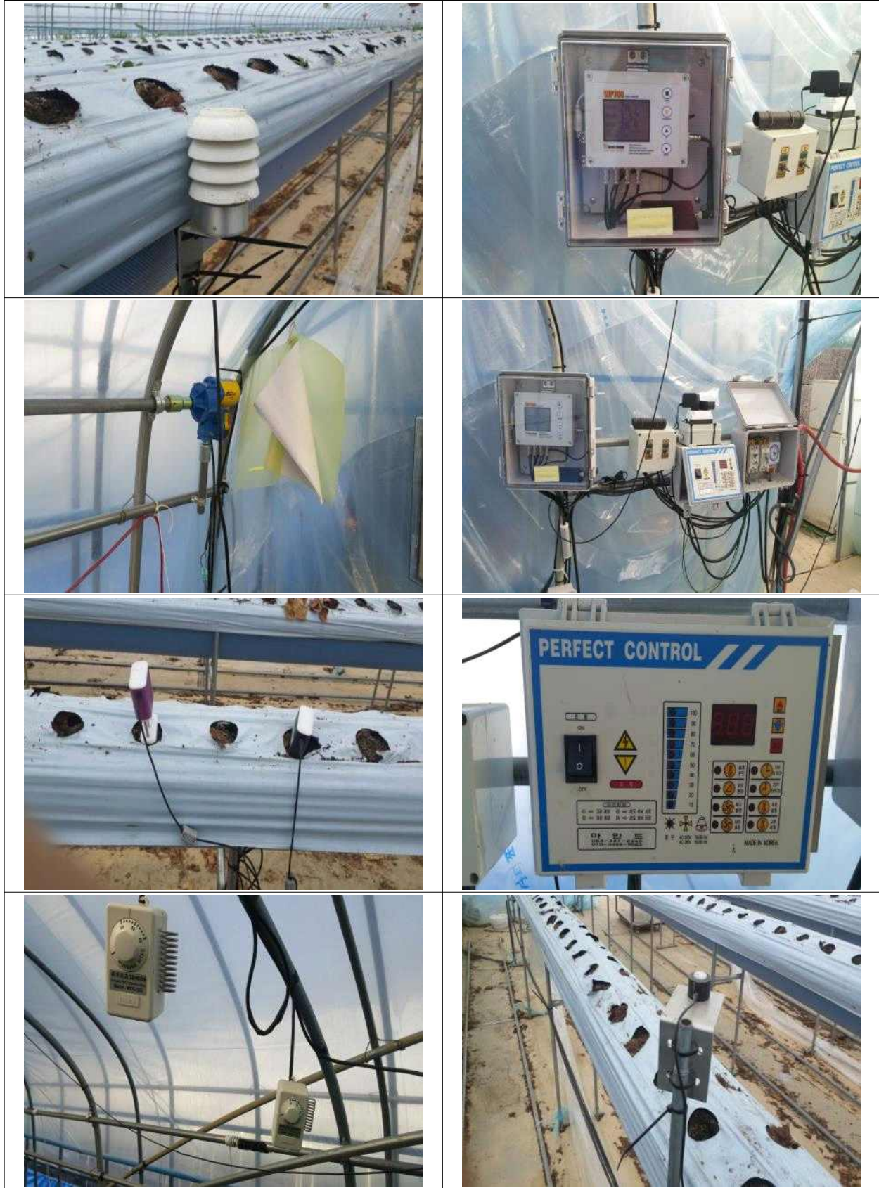
그림 43. 재배지 내 환경 모니터링 시스템 구축 설치 시스템 보완
