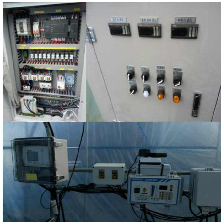
그림 26. 제습난방장치의 컨트롤 시스템 및 온실미세환경측정을위한 계측시스템
