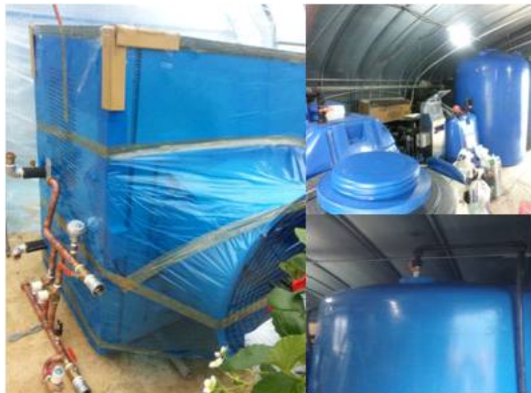
그림 24. 제습난방장치 현장 설치를 위한 장비 및 각종 부속 장치들
