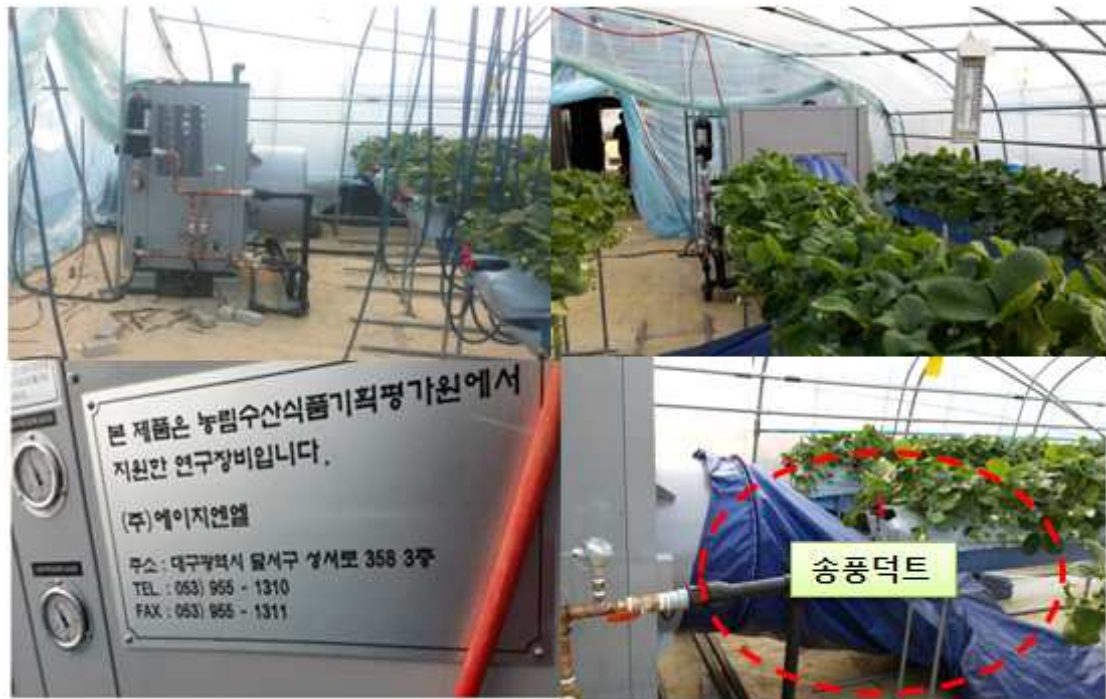
그림 22. 제습 난방장치 설치 전경
