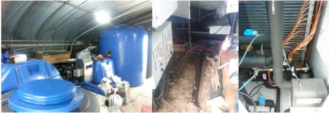
그림 25. 설치 공사 모습
