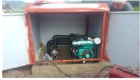
<양수 펌프 설치>
