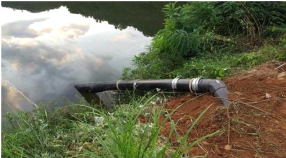
촬영 일자 2016. 07. 촬영 내용 유입부 관 고정 및 설치완료
