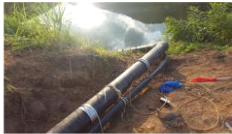
<PE 수도관 설치>
