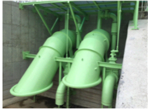
<산규 사이폰 설치>
