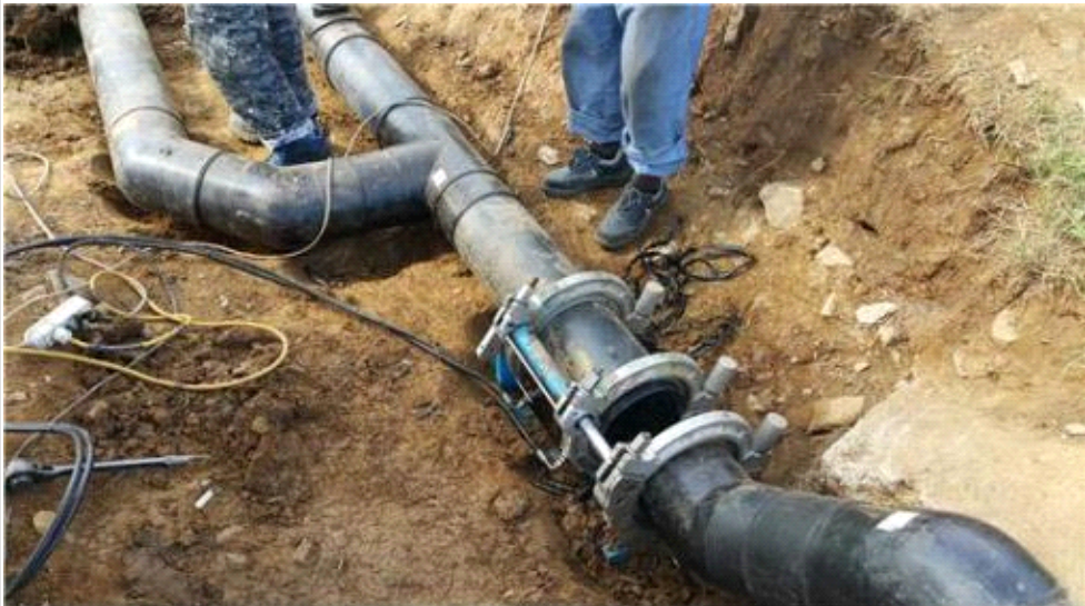
촬영 일자 2017. 07. 촬영 내용 PE 관 설치
