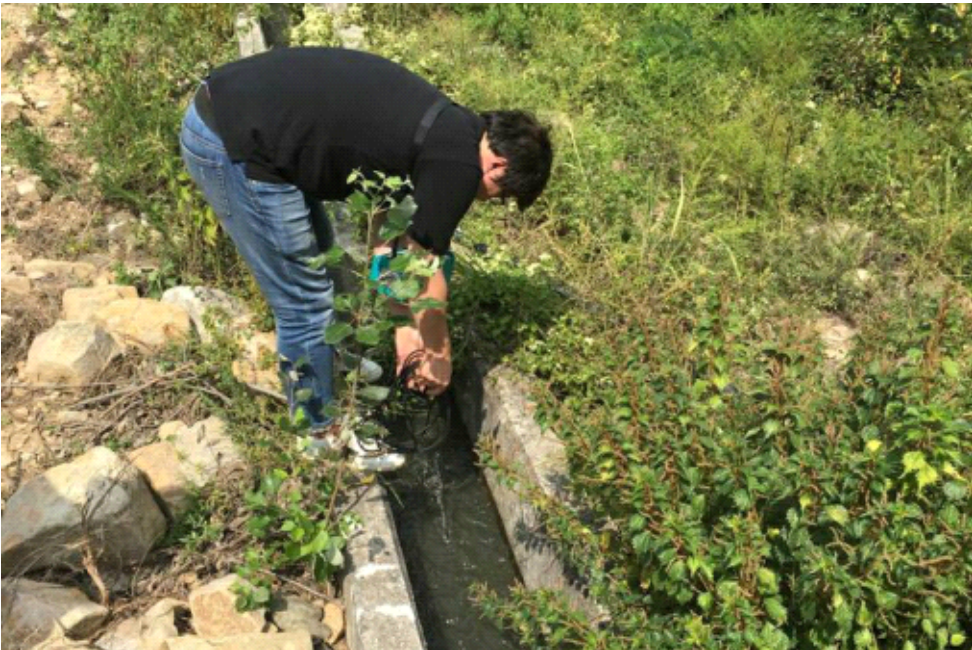
<그림 5-5> 사이폰 대체공법 현장시험 전경
