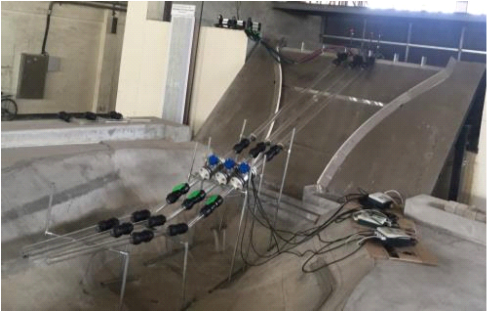
<사이폰 설치 전경(전체)>
