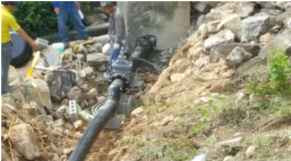
촬영 일자 2016. 07. 촬영 내용 유출부 설치
