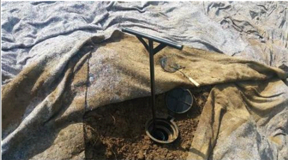
촬영 일자 2017. 07. 촬영 내용 유출부 설치후 되메우기 완료
