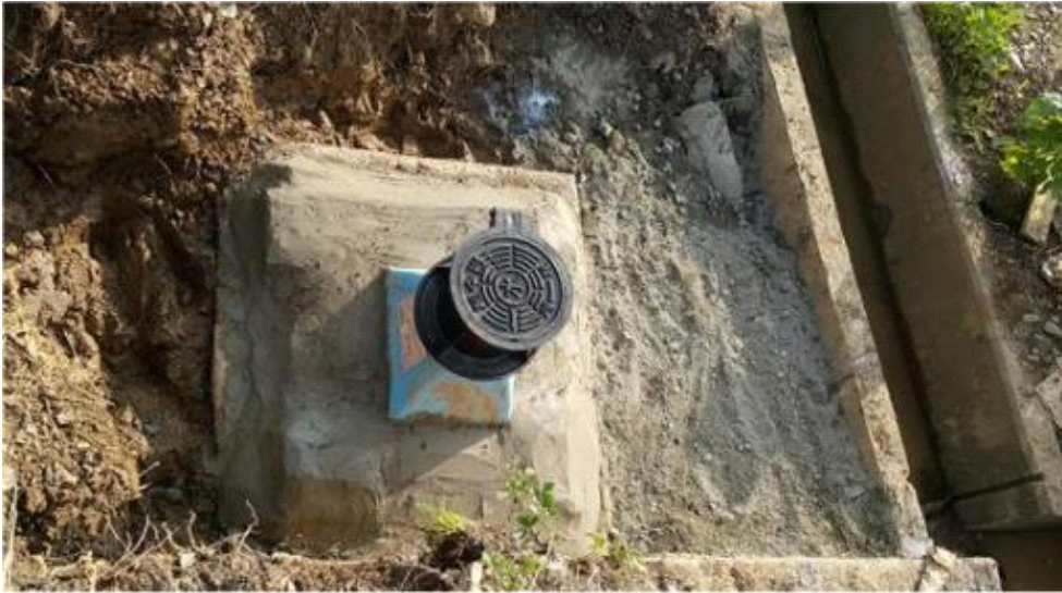
촬영 일자 2017. 07. 촬영 내용 제수밸브 보호통 설치
