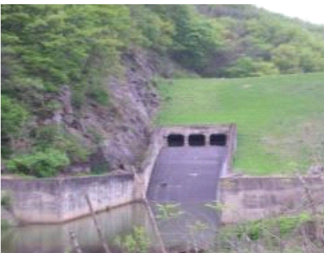
<기존 사이폰 설치현황(3련)>
