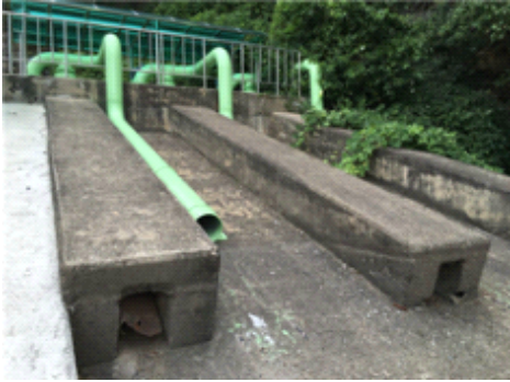
<기존 사이폰 에어벤트 설치>
