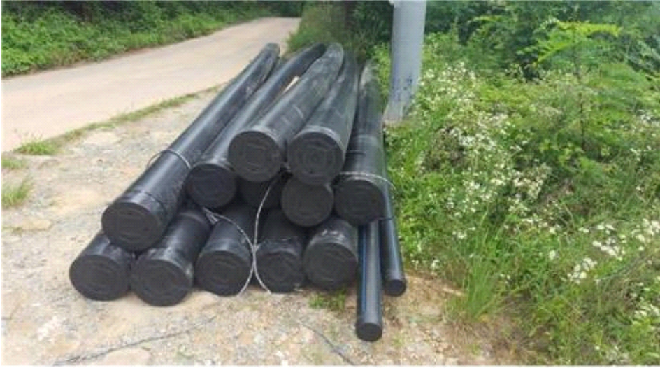
촬영 일자 2016. 07. 촬영 내용 PE 관 자재 현장 입고
