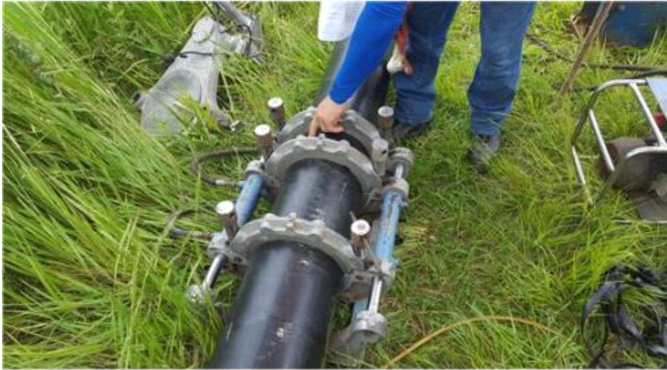
촬영 일자 2016. 07. 촬영 내용 PE관 버트용착
