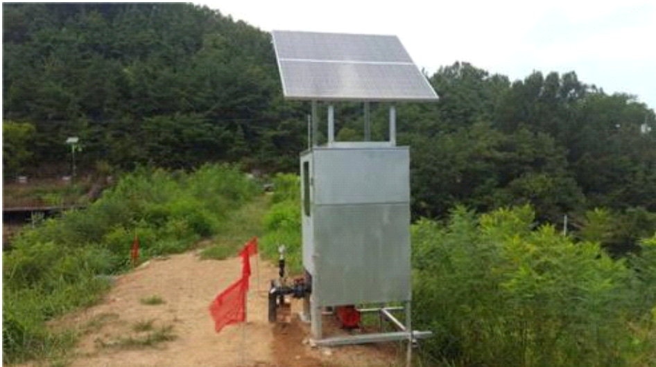
촬영 일자 2016. 07. 촬영 내용 전원장치 및 대체공법 설치 완료
