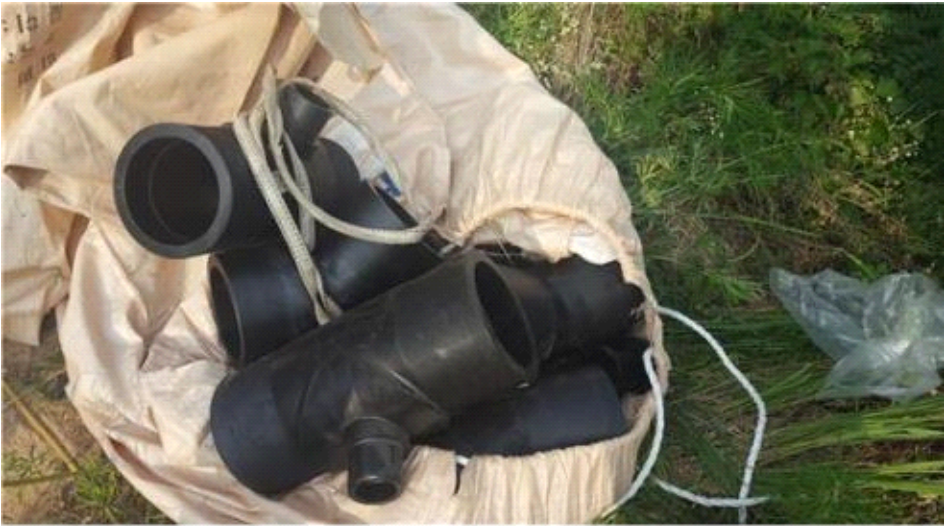
촬영 일자 2016. 07. 촬영 내용 PE 관 부속자재 현장 입고
