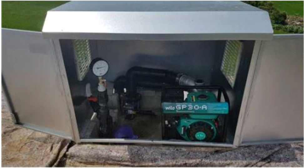
촬영 일자 2017. 08. 촬영 내용 압력 계측1
