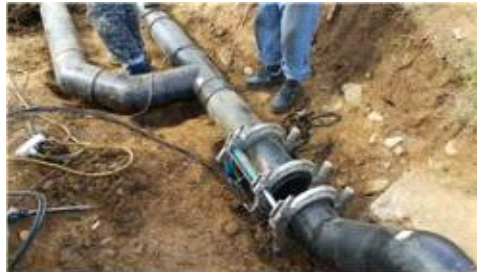
<PE 수도관 설치>
