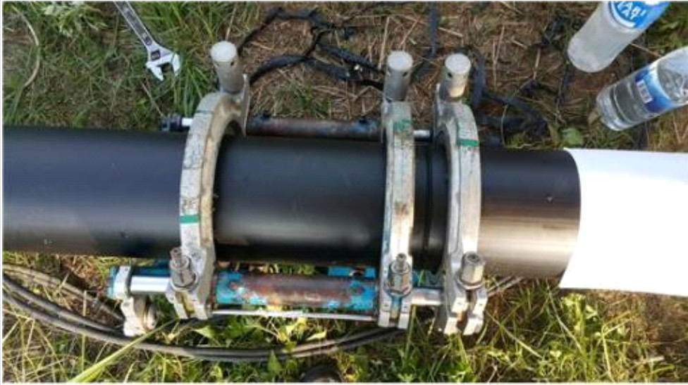
촬영 일자 2017. 07. 촬영 내용 PE관 버트용착
