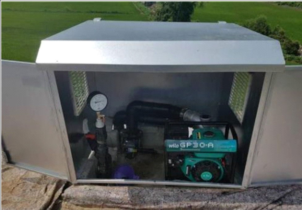
촬영 일자 2017. 07. 촬영 내용 제당부 배관 및 펌프, 밸브설치
