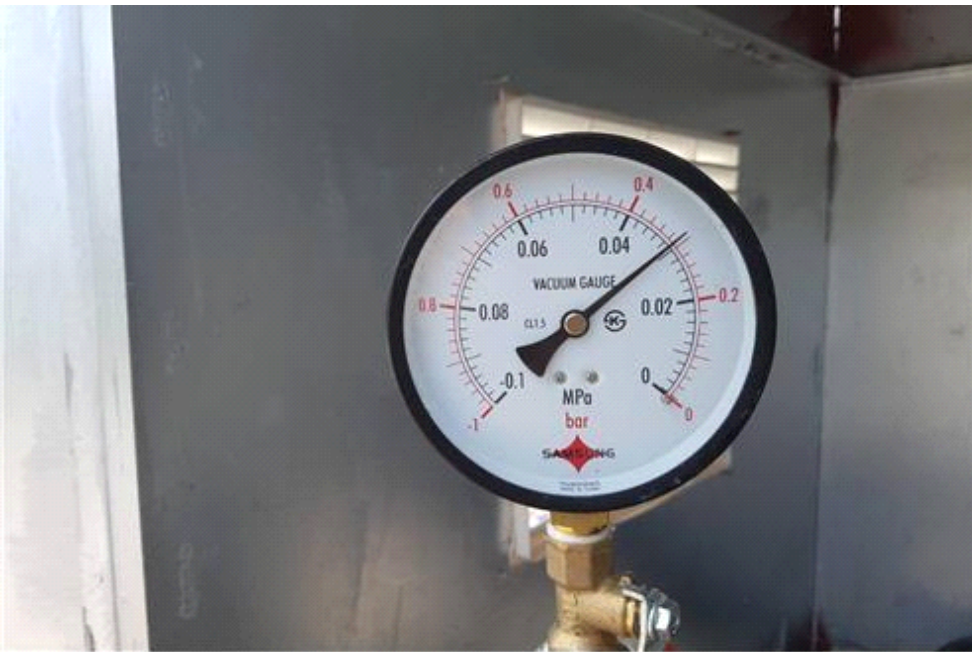
촬영 일자 2017. 08. 촬영 내용 압력 계측2
