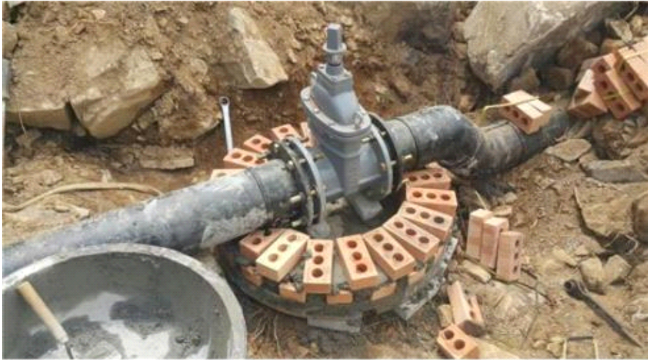
촬영 일자 2016. 07. 촬영 내용 제수밸브 보호통 설치
