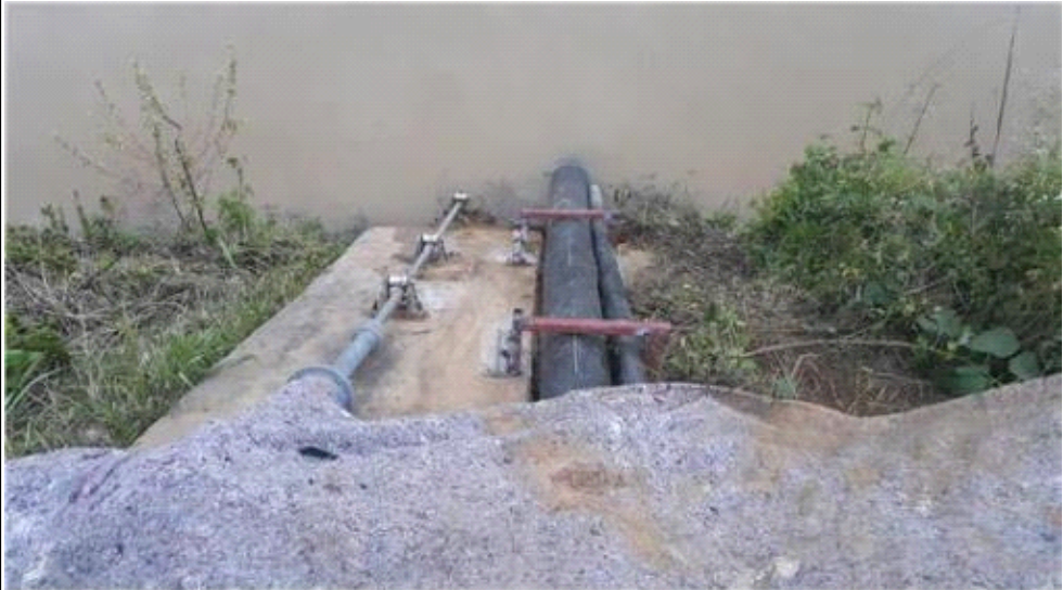
촬영 일자 2017. 07. 촬영 내용 유입부 관 고정 및 설치완료
