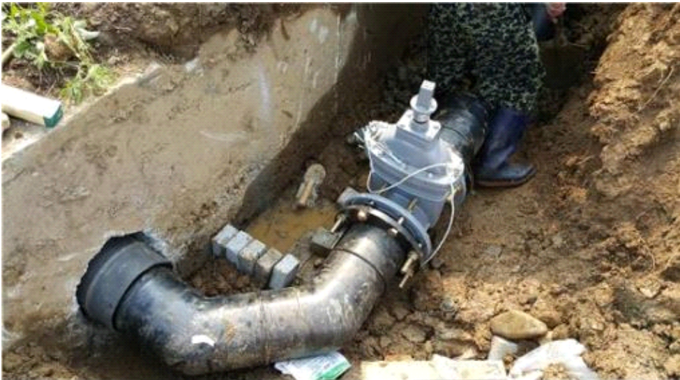
촬영 일자 2017. 07. 촬영 내용 유출부 설치
