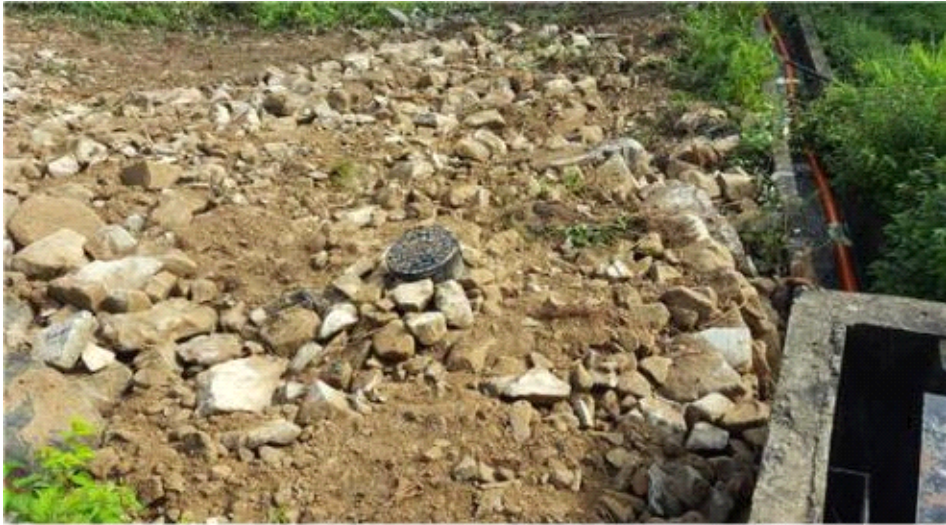
촬영 일자 2016. 07. 촬영 내용 유출부 설치후 되메우기 완료
