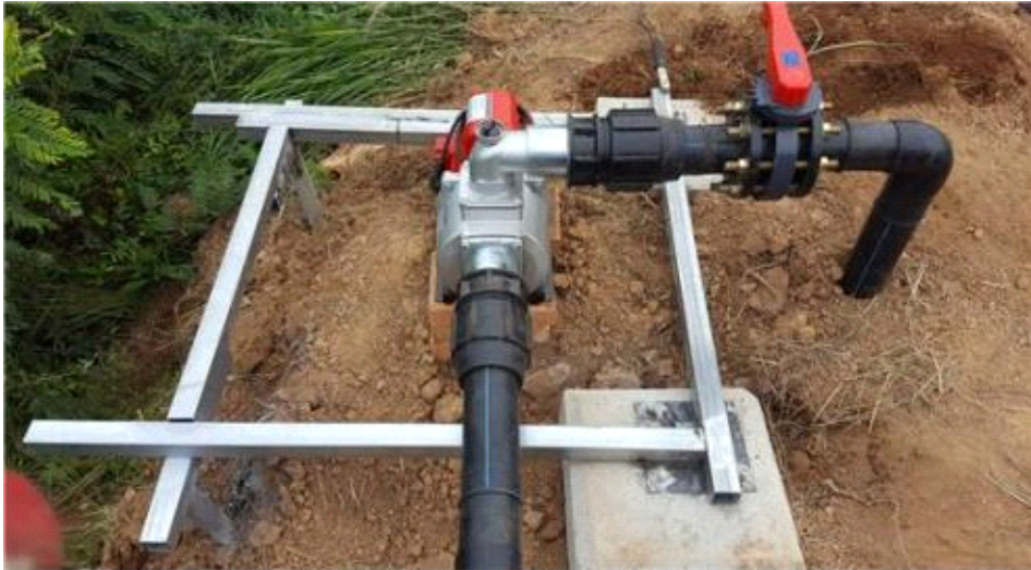
촬영 일자 2016. 07. 촬영 내용 전원장치 기초 설치
