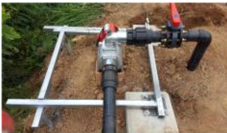
<양수 펌프 설치>
