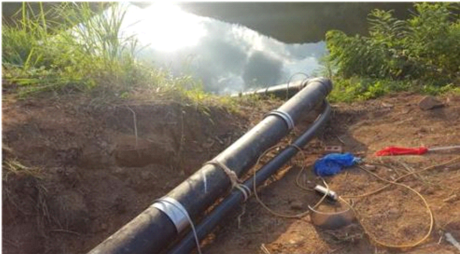
촬영 일자 2016. 07. 촬영 내용 PE 관 설치
