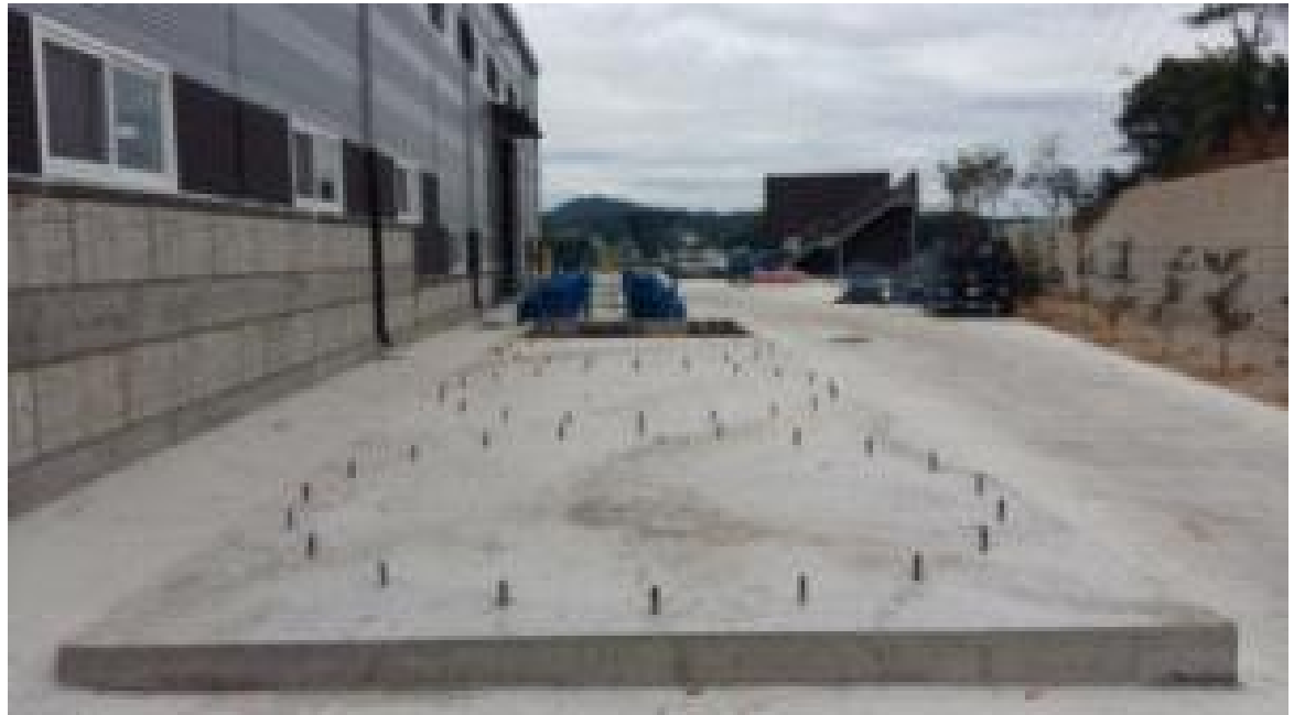
<부산물사료 발효저장조 설치기초공사>
