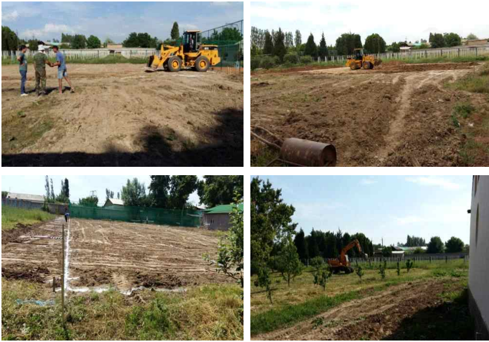
[그림 144] 내재해형 광폭 비닐온실 부지조성 공사
