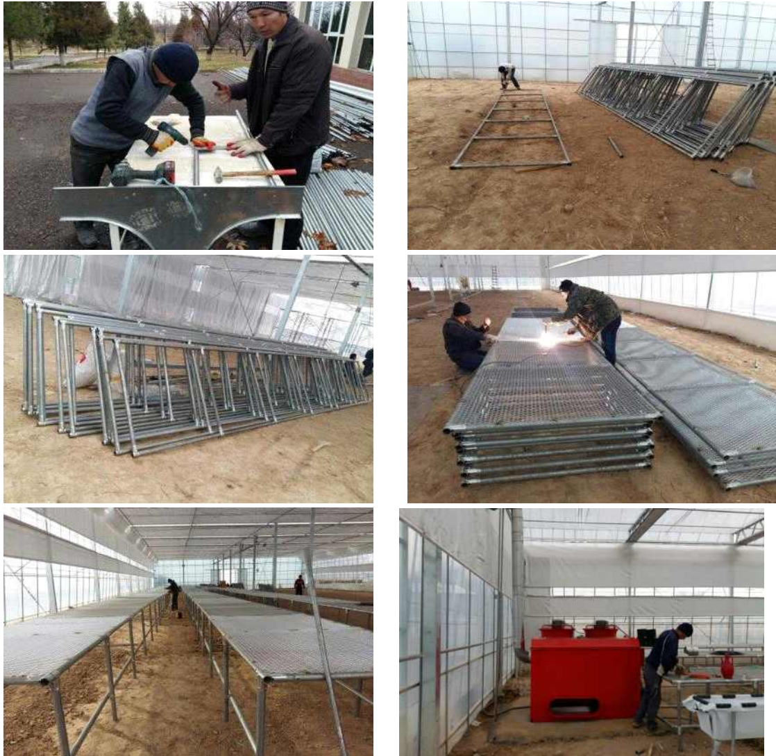
[그림 166] 분재 재배용 베드 공사
