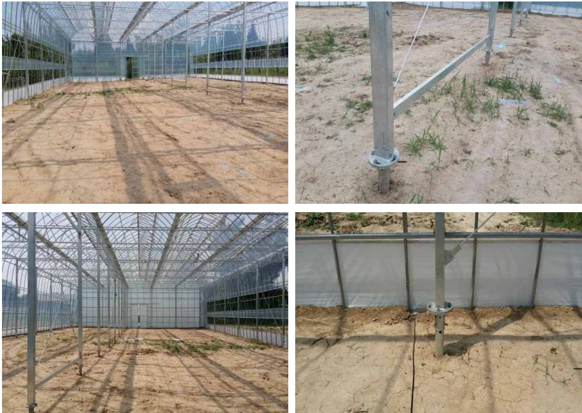
[그림 155] 내재해형 광폭 비닐온실 기초 및 주기둥 검수
