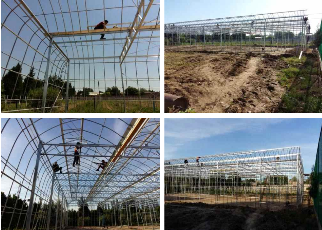
[그림 150] 내재해형 광폭 비닐온실 곡부물받이 및 천창 시공
