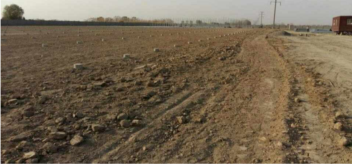
[그림 233] 온실 부지조성 및 기초 공사
