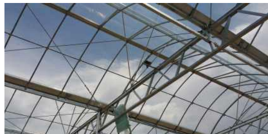
광 센서 설치
