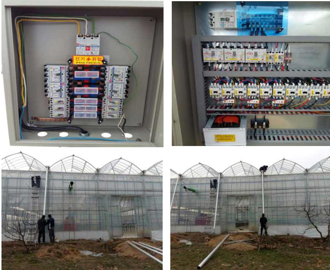
[그림 171] 환경설비 전원 및 물받이 공사
