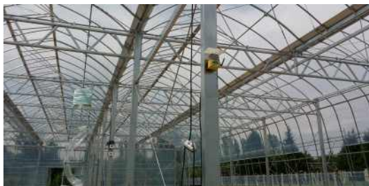
내부 온습도 센서 설치
