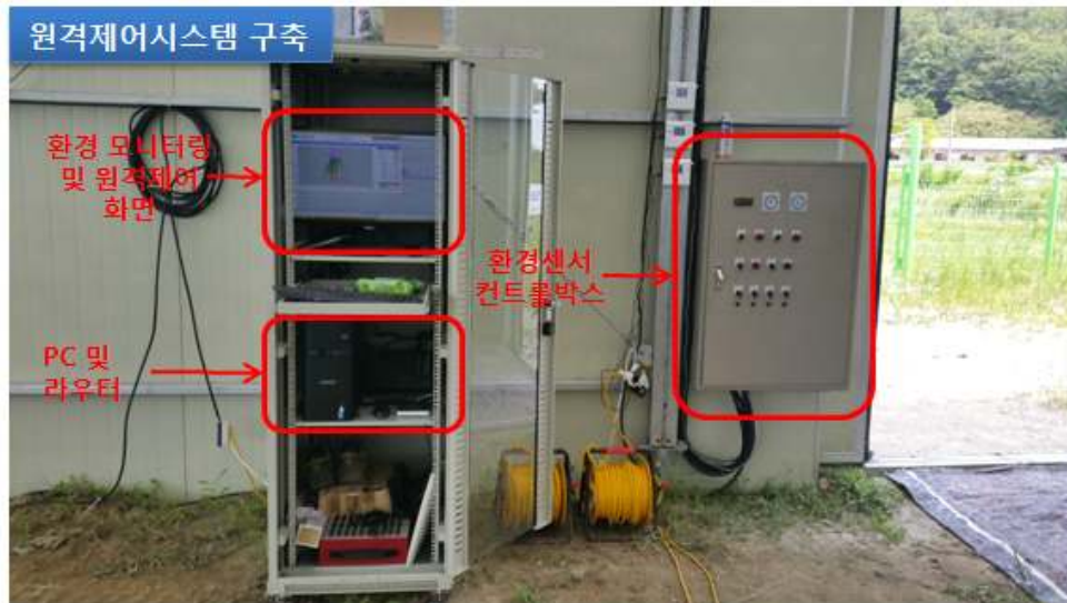
[그림 209] 데모온실 내 구축된 IoT기반 온실모니터링 및 원격환경제어시스템
