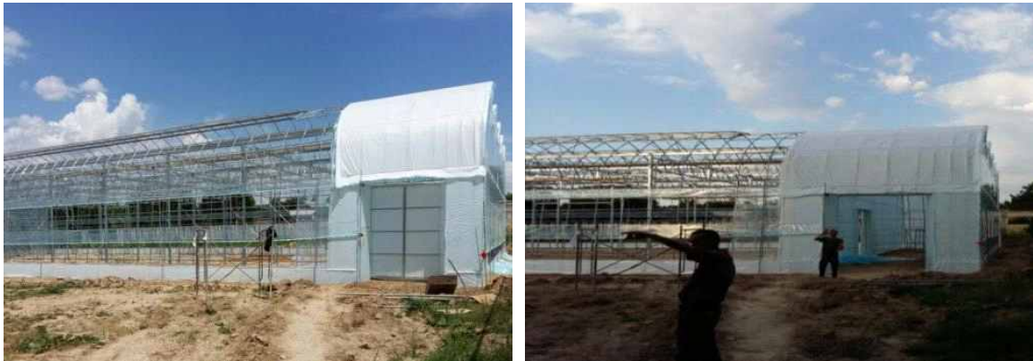
[그림 152] 내재해형 광폭 비닐온실 관리실 시공
