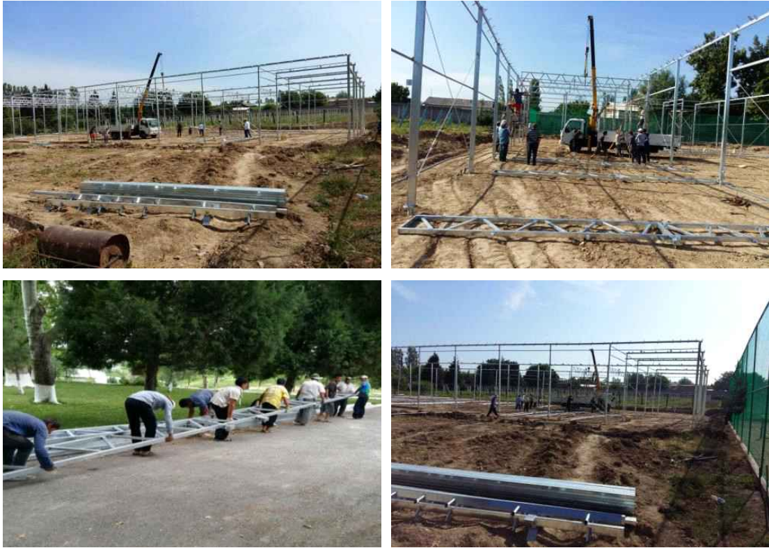
[그림 147] 내재해형 광폭 비닐온실 트러스 시공
