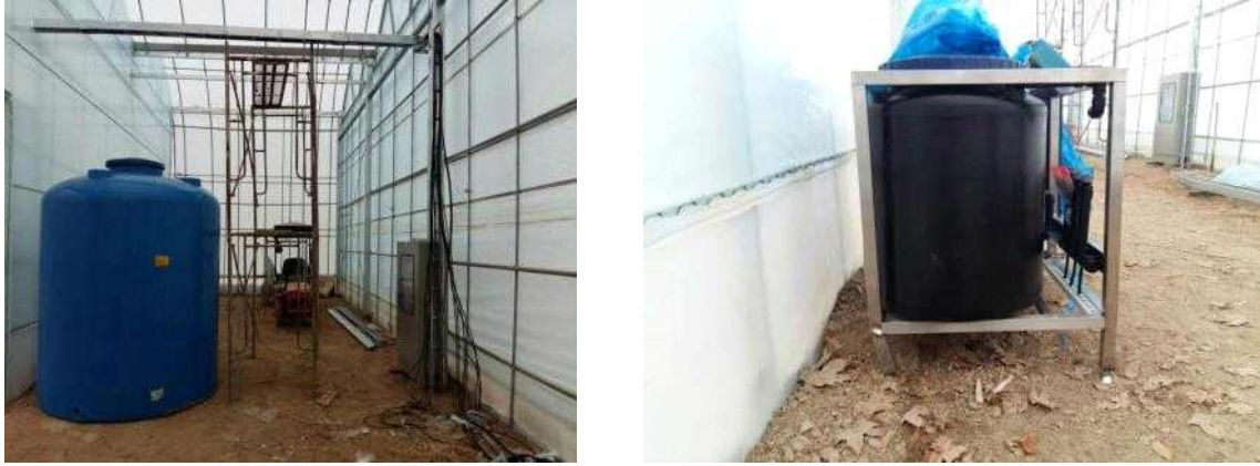
[그림 170] 양액 공급 및 관수 설비 공사
