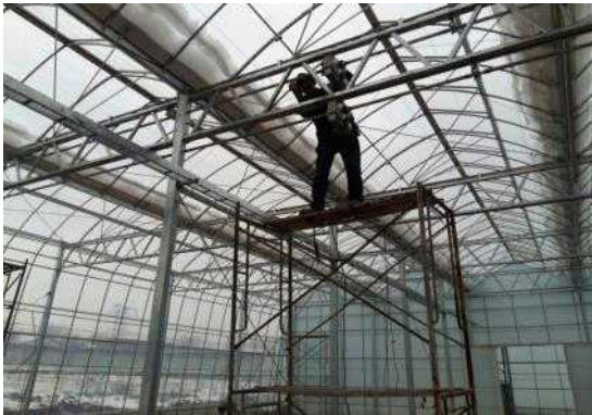
구동 모터 설치
