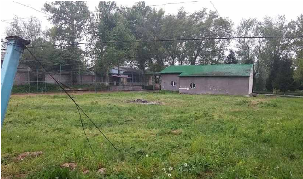
[그림 135] 우즈베키스탄 현지 온실부지 전경
