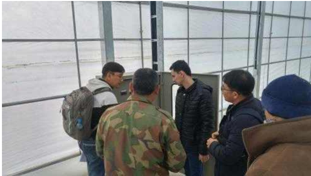
환경설비 전원 및 제어
