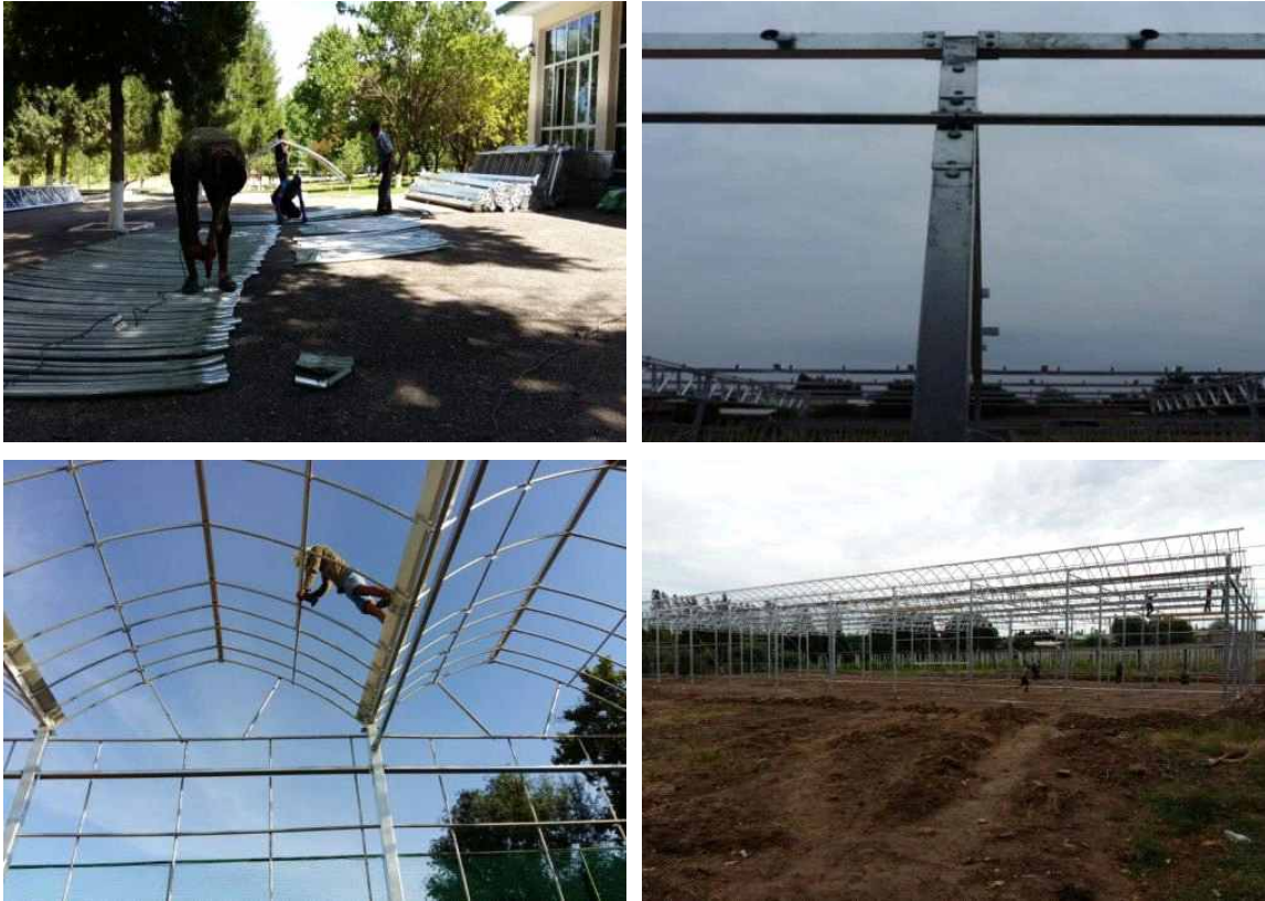
[그림 148] 내재해형 광폭 비닐온실 지붕서까래 시공
