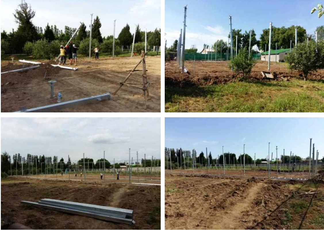
[그림 146] 내재해형 광폭 비닐온실 주기둥 시공
