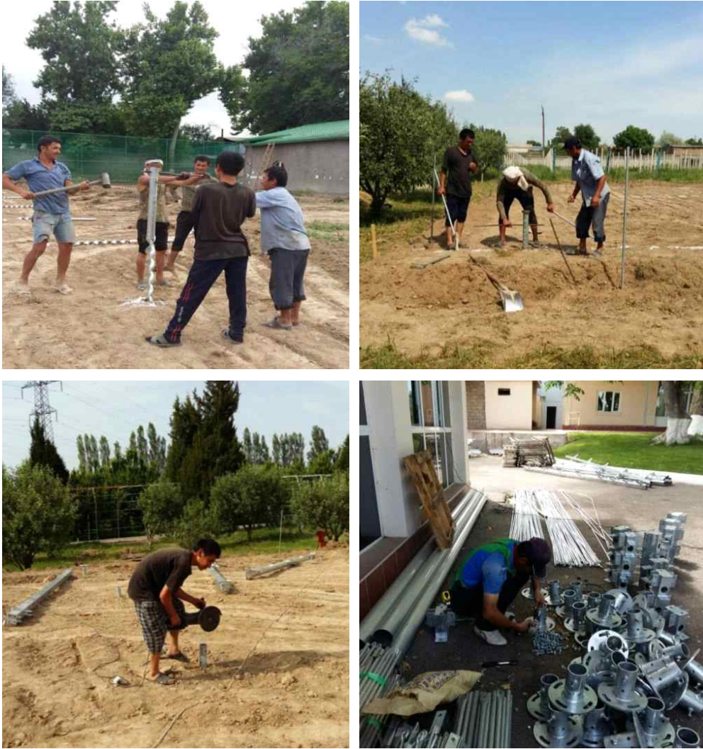
[그림 145] 내재해형 광폭 비닐온실 기초 시공
