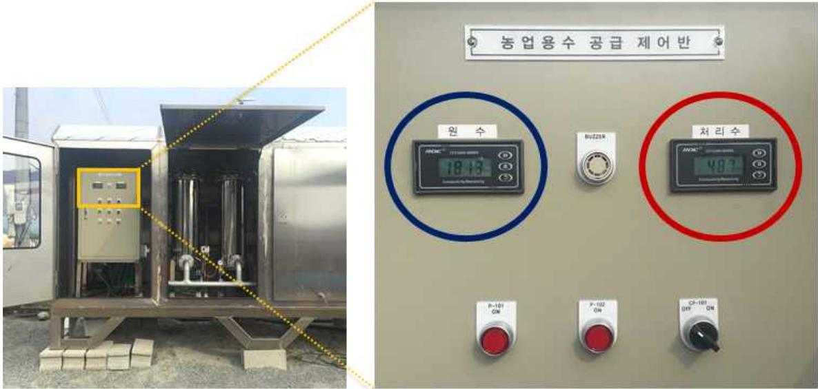
그림 7.25 기수담수 시스템 EC 농도 측정
