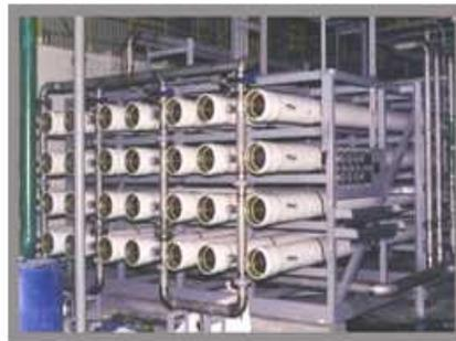
그림 5.19 RO 멤브레인 구조 및 설치
