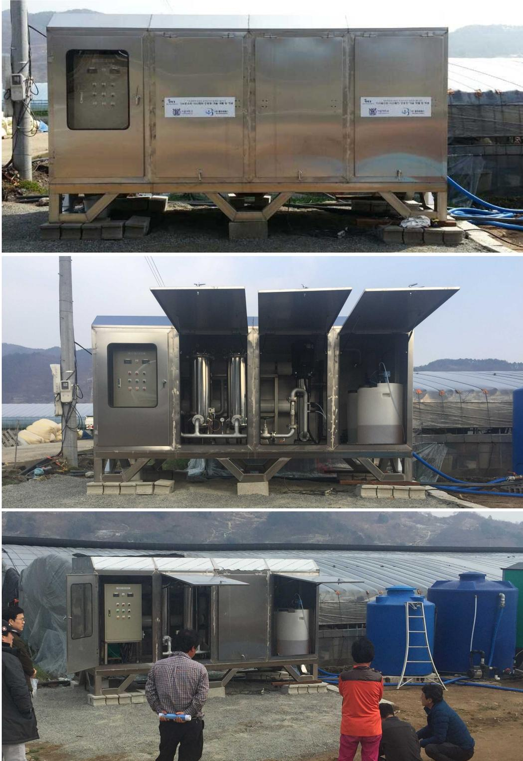
그림 7.20 고흥 현장지구의 기수담수화 시스템 설치 및 가동
