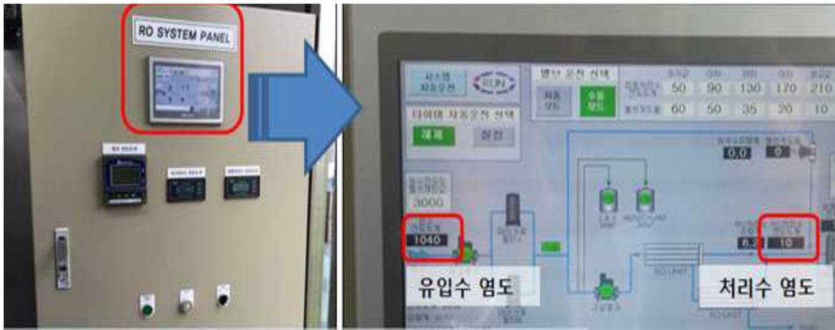
그림 8.13 자동 지능형 제어방식의 운전 모니터링 화면 예시
