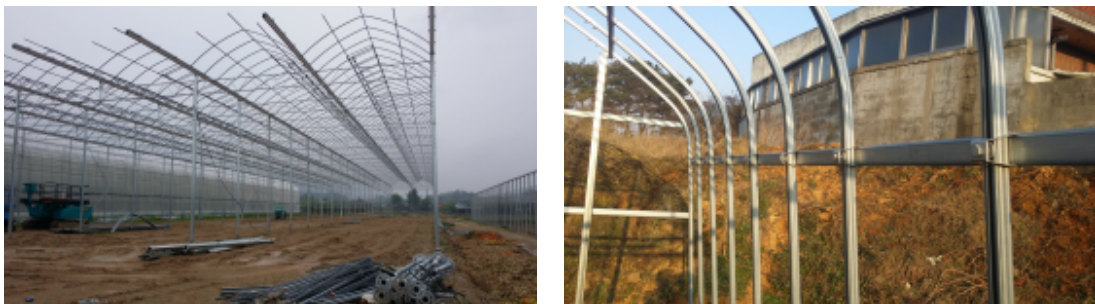
[그림 5] 제안모델 설치 및 부속자재 결합 모습
