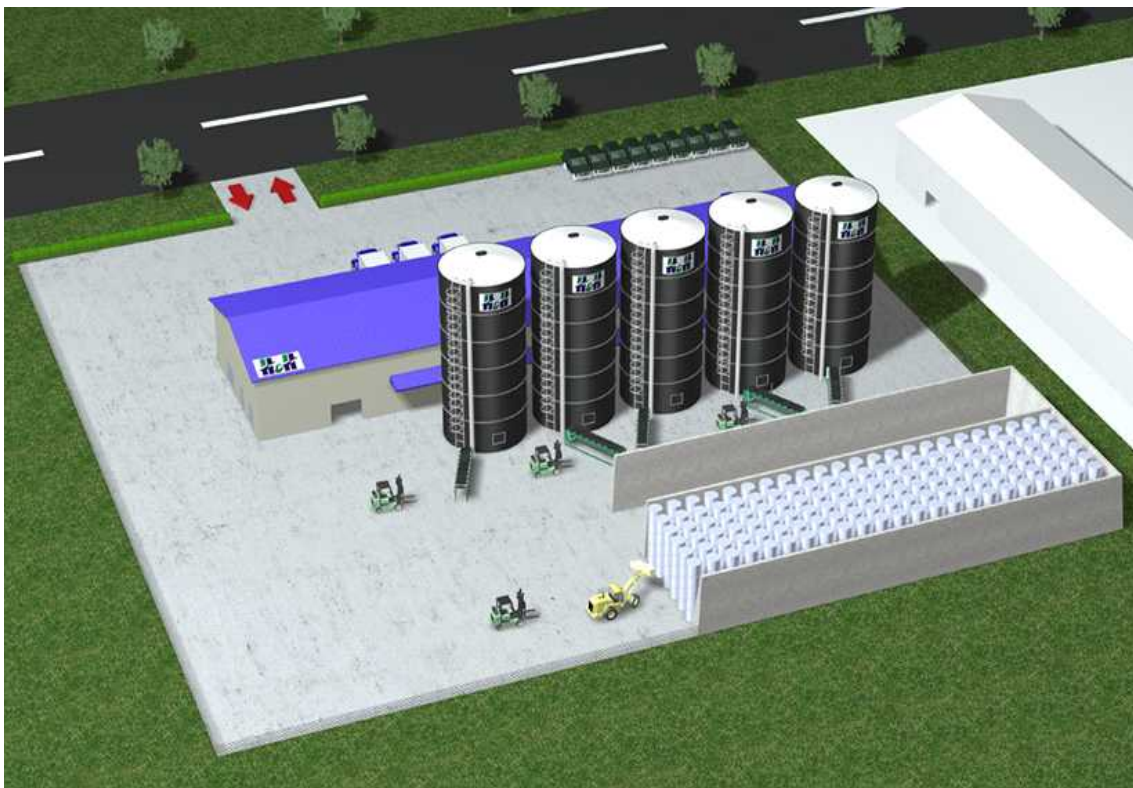
<그림 V-17> TMR사료공장, 곤포사일리지, 수직형 기밀식 사일로
