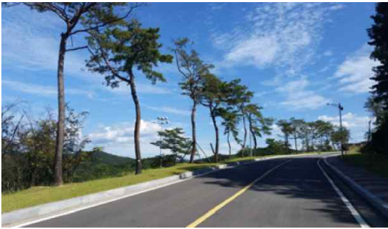
그림 3-4-19. 아스팔트 포장 도로
