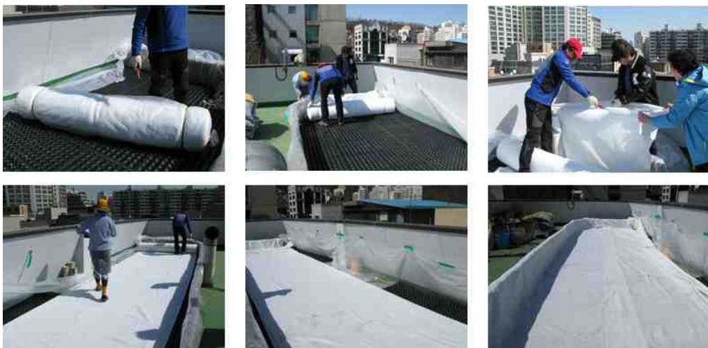
그림 3.1.49 옥상텃밭 조성 (부직포 설치).
