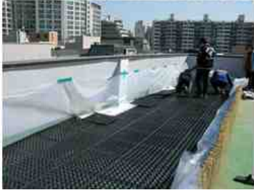
그림 3.1.48 옥상텃밭 조성 (차수막 및 배수판 설치).
