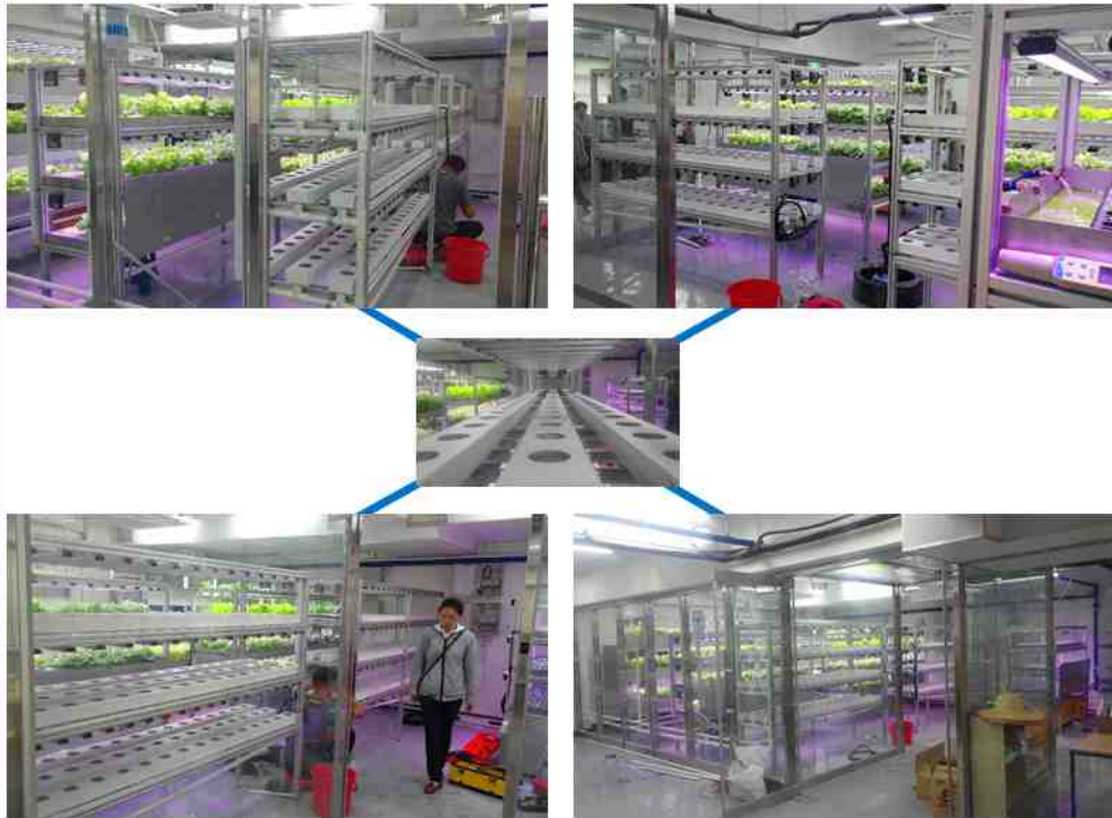
그림 3.1.17 NFT 3호기와 4호기 설치공사.
