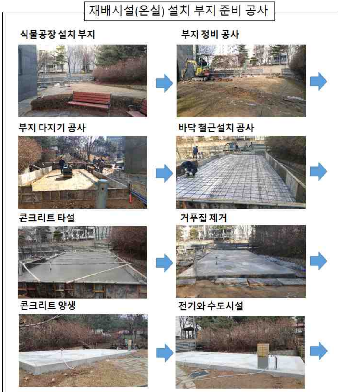
그림 3.1.24 온실 신축을 위한 부지준비공사 과정.
