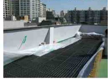
그림 3.1.48 옥상텃밭 조성 (차수막 및 배수판 설치).
