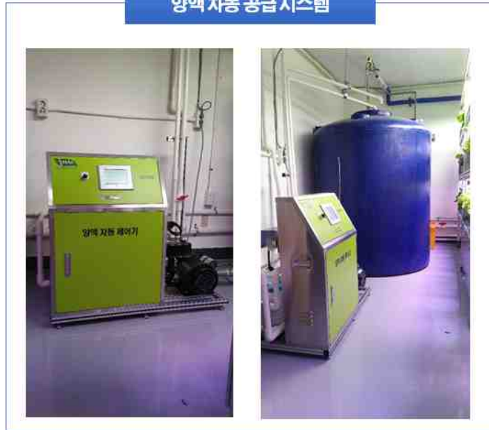
그림 3.1.21 양액 자동 공급 시스템.
