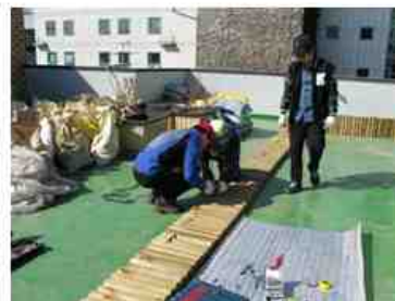
그림 3.147 옥상텃밭 조성 (테두리목 설치).
