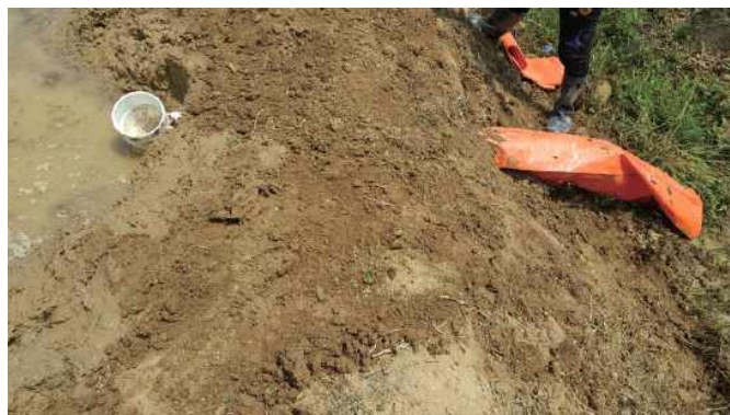
<논두렁에 튼튼하게 설치된 배수물꼬 사례>
