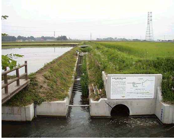
<상부수로와 배수로와의 낙차지점에 설치된 어도>
