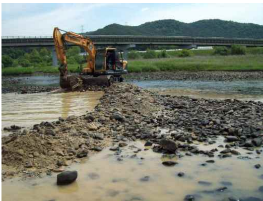
<하천 물 가두기 독 시공: 농어촌공사 순창지사>
