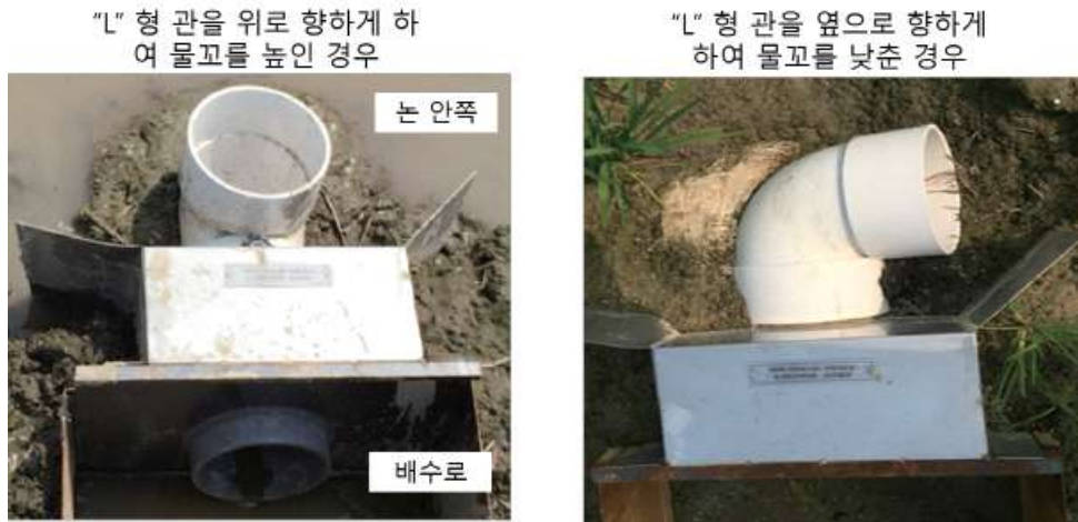
<“L”형 배수물꼬 설치 사례>
