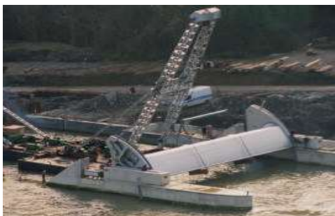
<그림 3-50> 레디얼 가동보(Radial Gate)
