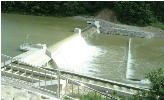
저수지 여수로 설치
