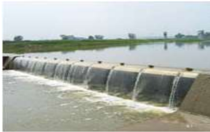
<그림 3-41> 유압식 가동보 설치 전경
