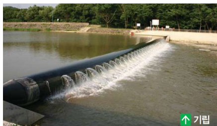
<그림 3-39> 기존 가동보 (고무보) 구성 및 기립/도복 형상
