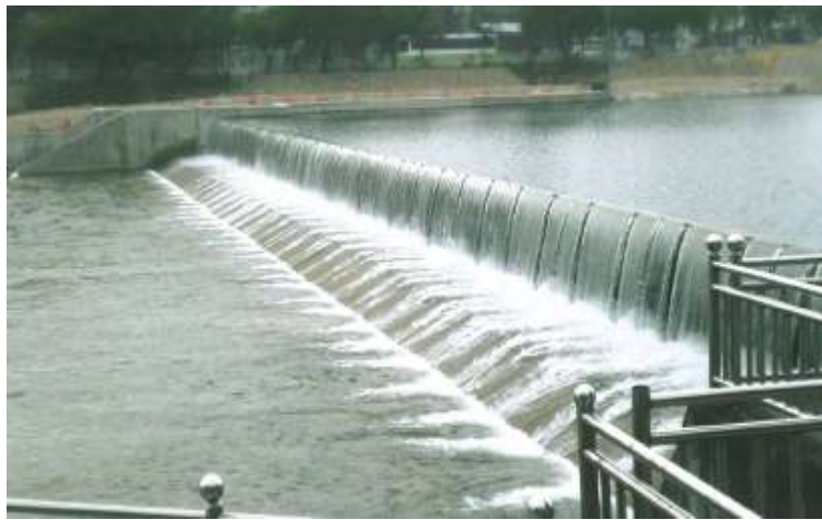
<그림 3-45> 고무철판 복합가동보 설치 전경
