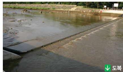
<그림 3-39> 기존 가동보 (고무보) 구성 및 기립/도복 형상
