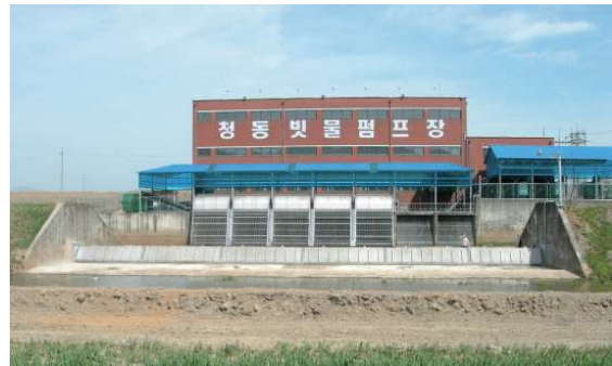
펌프장 유입부 설치
