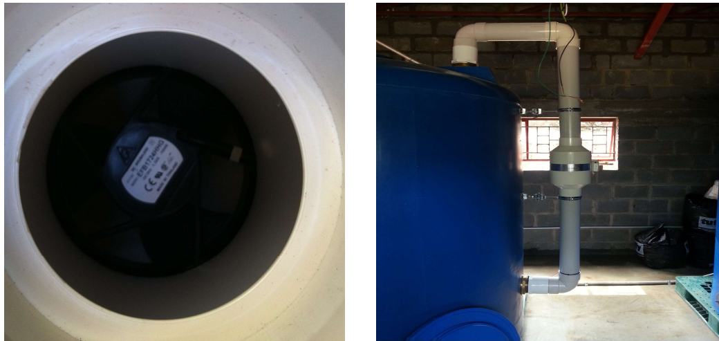
<그림 3-7> 순환형 에어팬과 적용 모습
