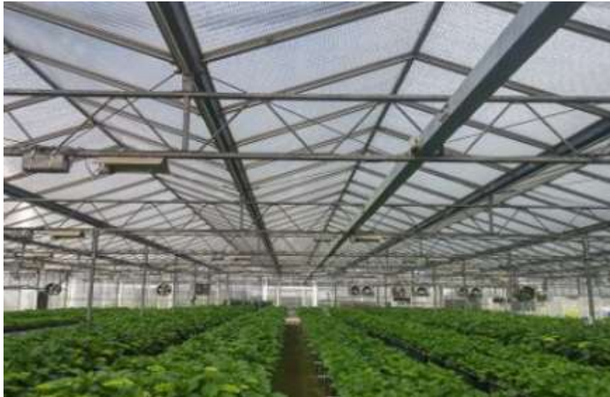
[그림 35] 시공 후 5년이 경과한 PMMA를 활용한 재배시설
