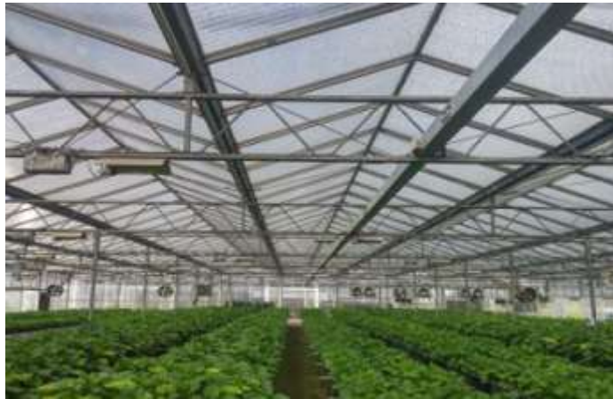
< 시공 후 5년이 경과한 PMMA를 활용한 재배시설 >
