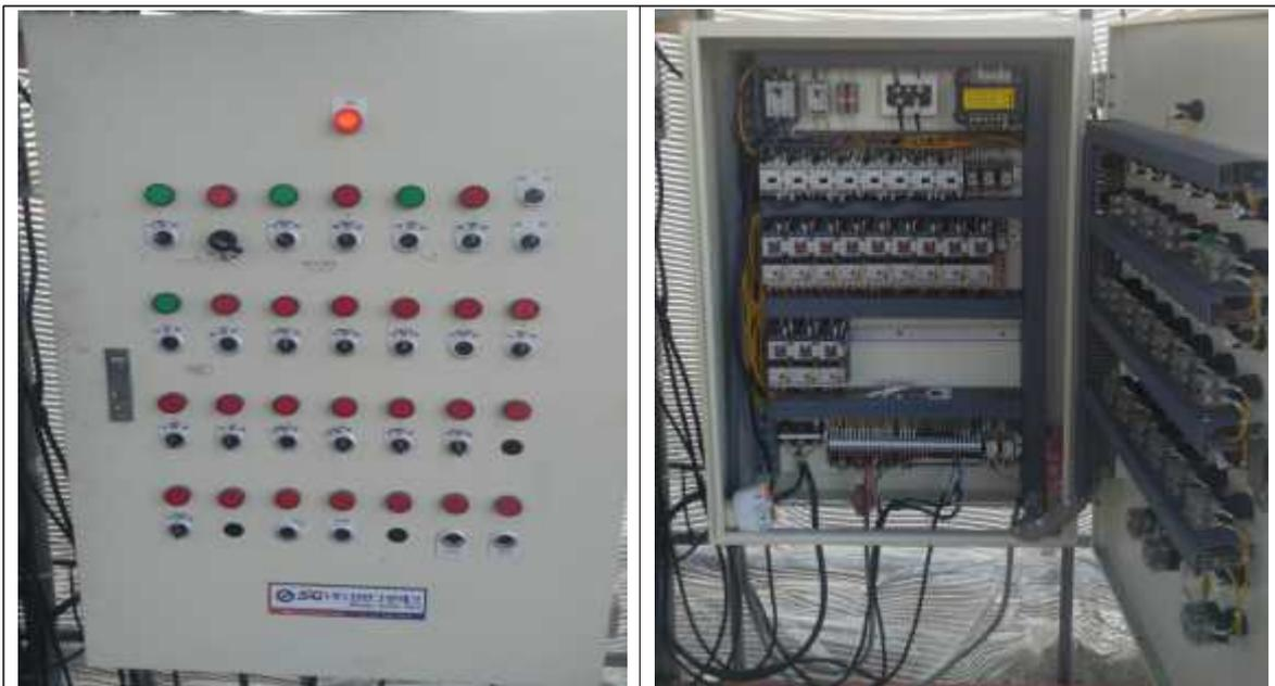
그림 3-5-28. 통합제어 판넬 내부에 각 시스템과 연결된 모습(좌: 외부, 우: 내부)
