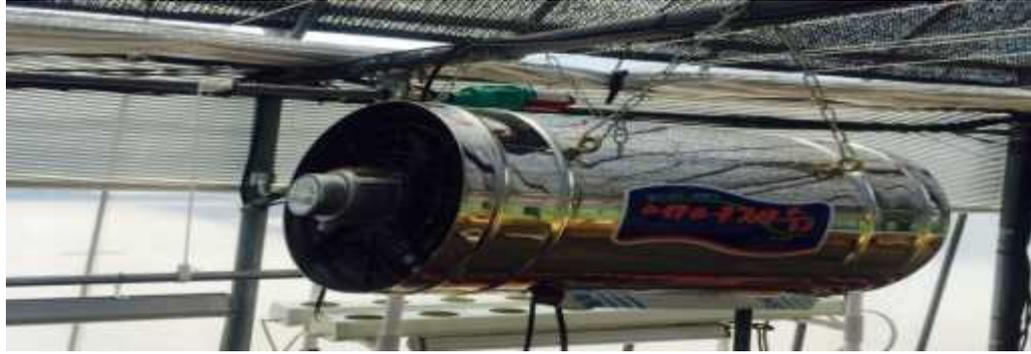
그림 3-5-11. 통제시스템을 확인하기 위해 시설 내부에 설치된농용공기교반제습기
