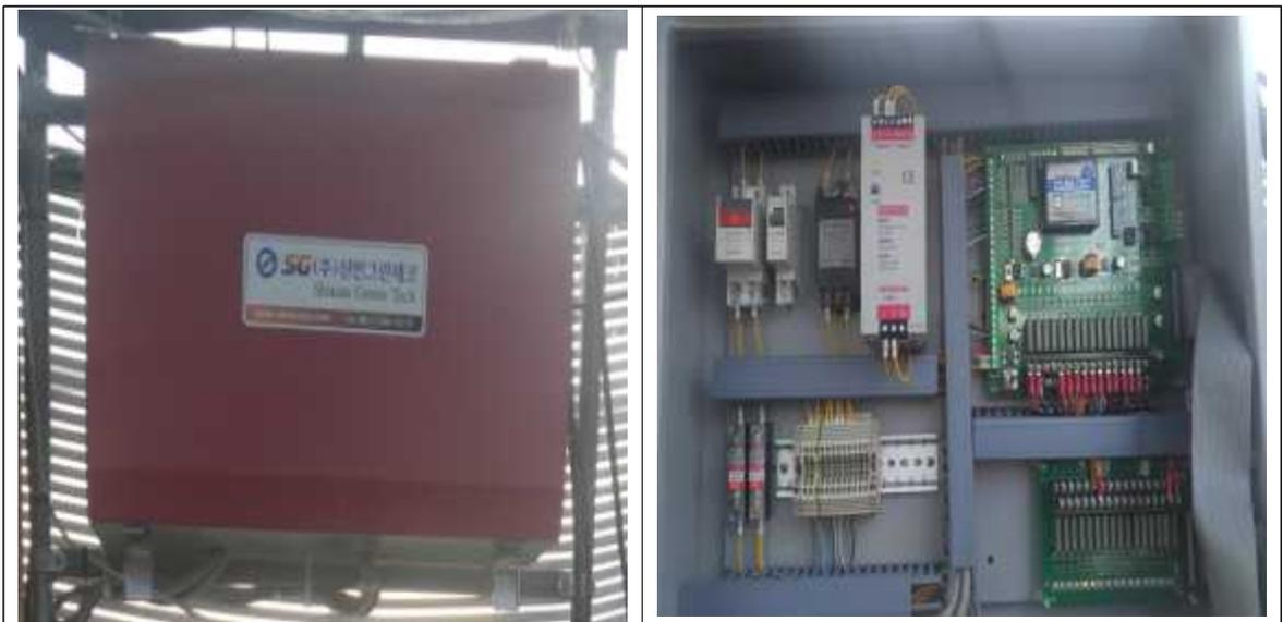
그림 3-5-30. 무선으로 데이터를 습득하는 통신제어함 내부
