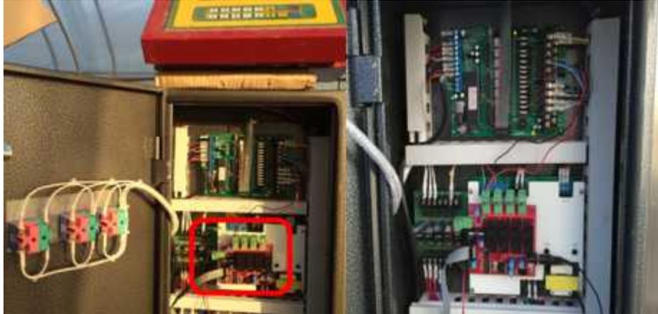
그림 3-2-46. 릴레이를 이용한 솔레노이드 밸브의 제어시스템
