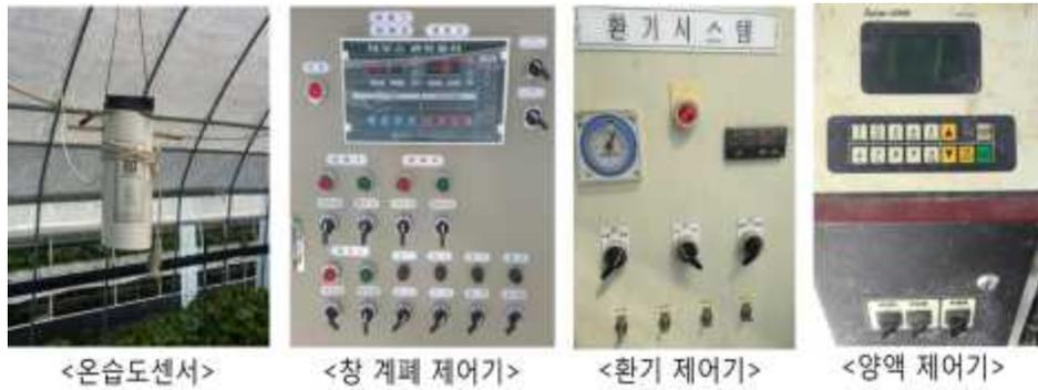
그림 3-2-62. 2차 실험 현장의 주요 온실 환경 계측 및 제어 구성 요소
