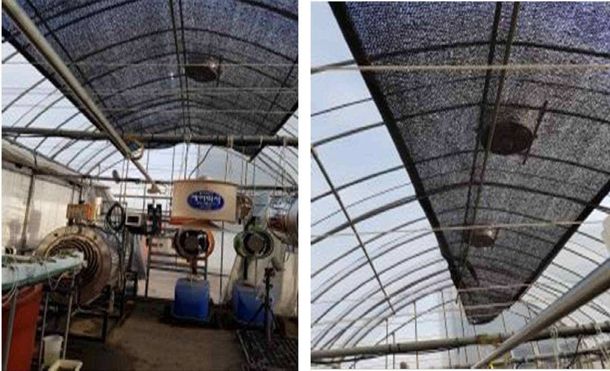
그림 3-1-58. 온도센서로부터 받는 데이터에 따른 차광막 작동
