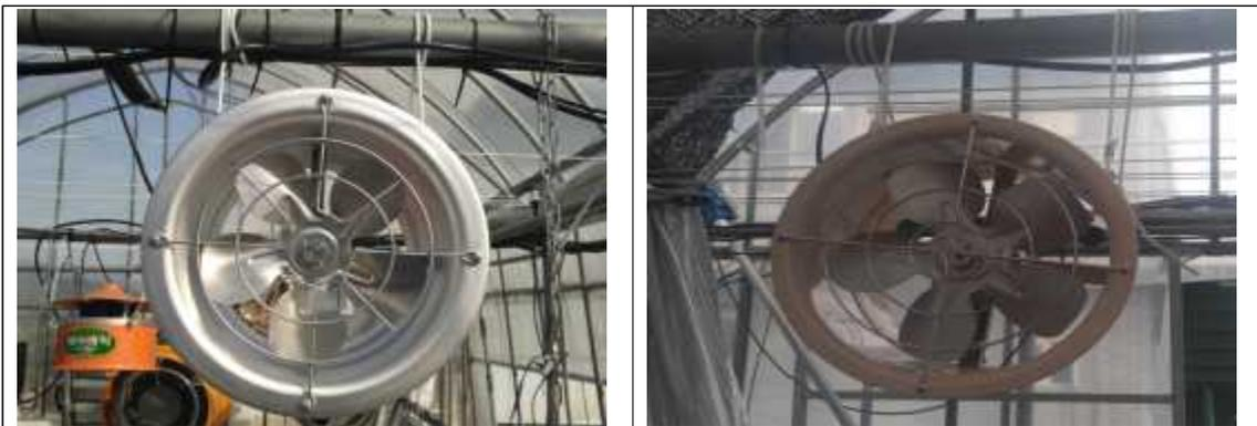
그림 3-5-16. 통제시스템을 확인하기 위해 시설 내부에 설치된 알루미늄공기유동팬/소형공기유동팬
