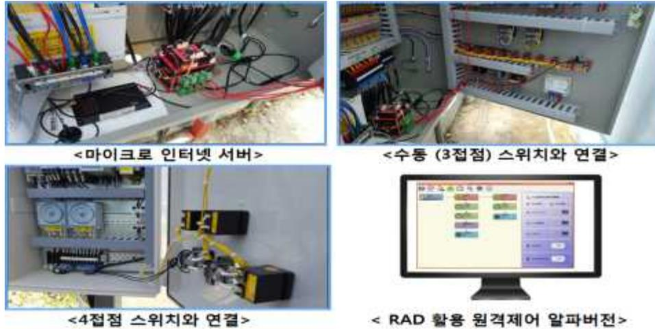
그림 3-2-83. 현장에 설치된 인터넷기반 온실 환경 원격 제어 시스템
