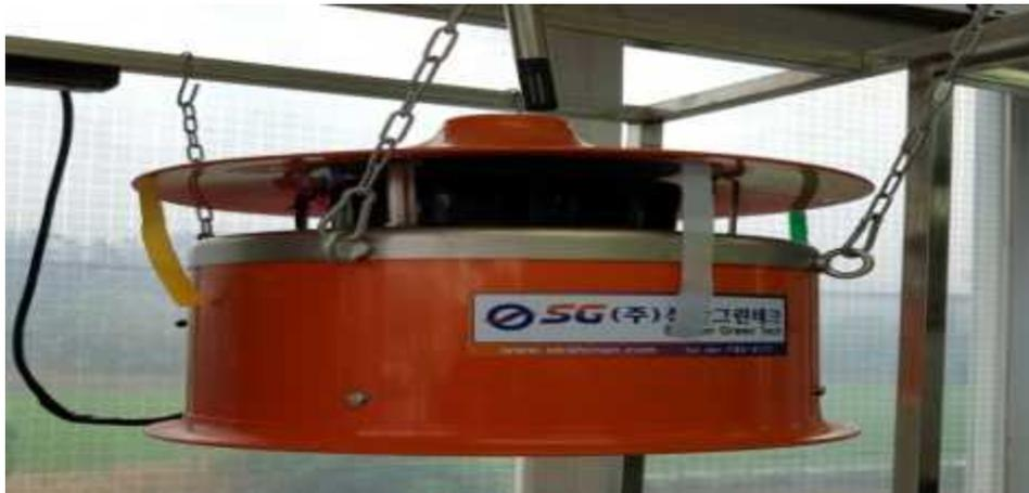
그림 3-5-12. 통제시스템을 확인하기 위해 시설 내부에 설치된 에어매직
