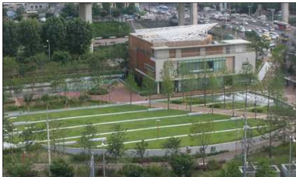
< 상부공원화 폐수처리시설 사례 >
