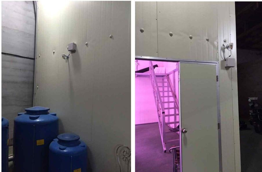
그림 9. 식물공장 모니터링용 고해상도 카메라의 설치(외부)
