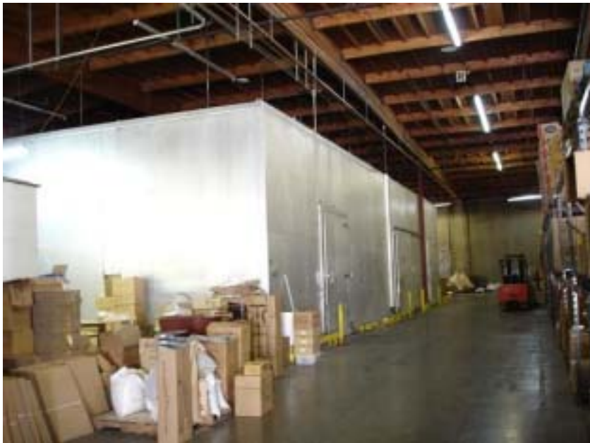
<사진 47> HANARO U.S.A INC.사 냉장창고
