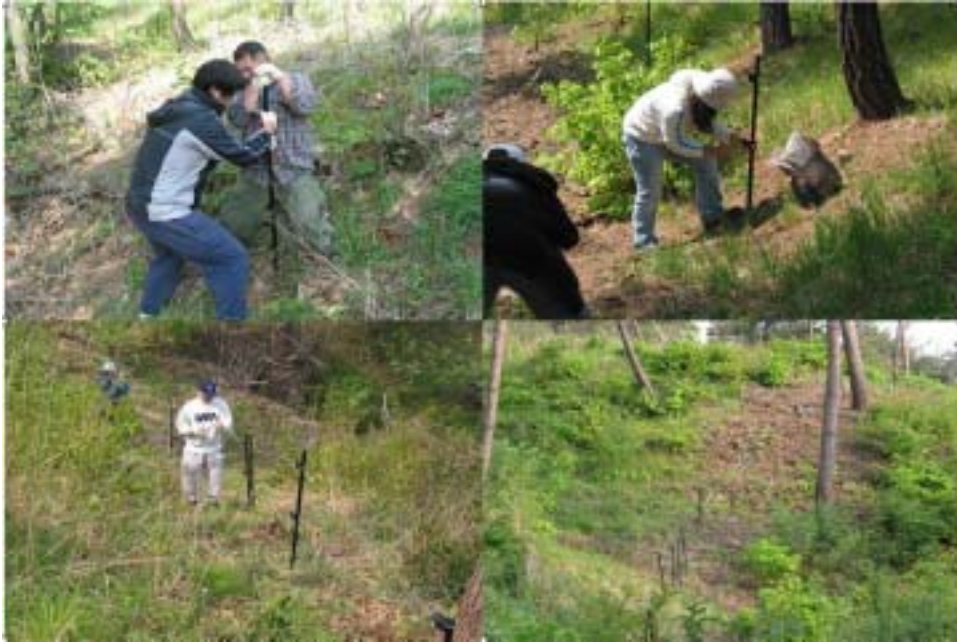
<사진 3-7> 태양열을 이용하는 전기목책의 설치.
