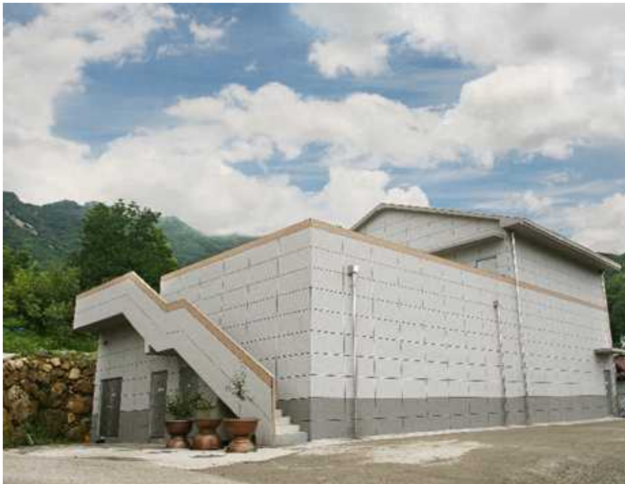
[에코맘의산골이유식 HACCP 이유식 전용 공장]
