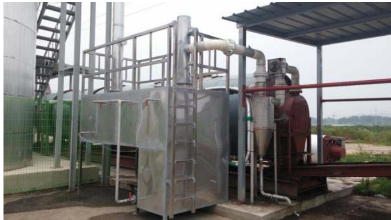
<그림-27> 복합악취처리 시스템
