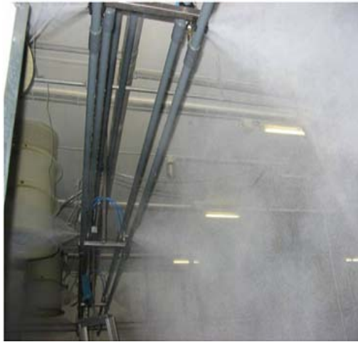
<그림-42> 가축분뇨 처리시설에 적용된 악취 제어용 분무 시스템 실물도
