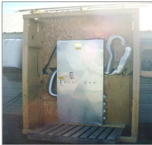
<그림-41> 가축분뇨 처리 시설에 적용된 악취 제어용 오존 발생기 실물도
