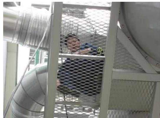
그림 3-2-50. 조선기 집진덕트의 타공 및 송풍량·정압 측정 장면(전북 익산보석우리밀영농조합법인)
