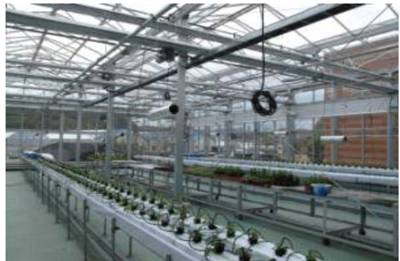
그림 1-4. 나노탄소섬유적외선 난방등(좌)과 경상대학교 벤로형 유리온실에 설치되어 있는 나노탄소섬유적외선 난방등(우).
