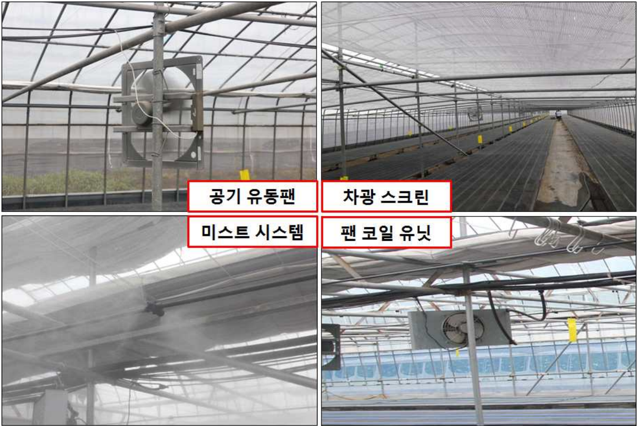
그림 2-56. 실험에 이용된 공기 유동팬, 차광 스크린, 미스트 시스템 및 팬 코일 유닛의 실제 모습.
