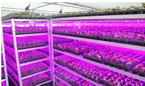
그림 1-8. LED 광원을 사용하고 있는 과채류의 접목활착실의 모습(전남의 장성육묘장).
