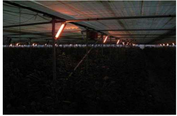
그림 1-5. 김해 진례면의 장미재배농가(1-2W 플라스틱 온실)에 설치된 나노탄소섬유적외선 난방등(좌)과 피복커튼이 설치된 야간의 나노탄소섬유적외선 난방등(우).
