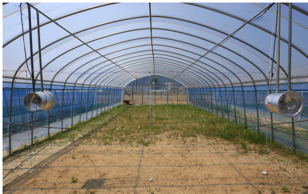
그림 2-94. 동일한 온실의 크기, 위치, 방향으로 건축된 4동의 온실 사진(상)과 단동 플라스틱 온실 내부의 공기 유동팬 설치 모습(중과 하).
