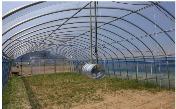
그림 2-94. 동일한 온실의 크기, 위치, 방향으로 건축된 4동의 온실 사진(상)과 단동 플라스틱 온실 내부의 공기 유동팬 설치 모습(중과 하).
