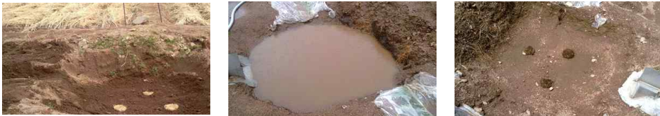
<그림 4-17> 침사구 설치 및 이용 사례
