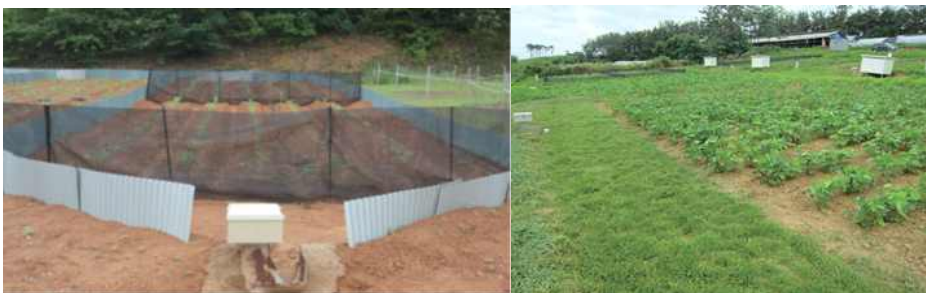
<그림 4-15> 실트펜스 및 잔디초생대 설치 예
