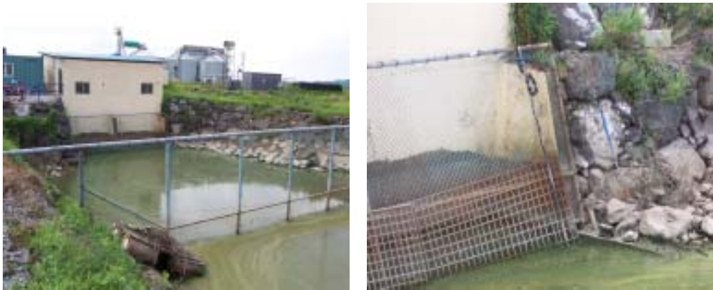
<그림 8-12> 간월양수장 염해예보시스템 설치
