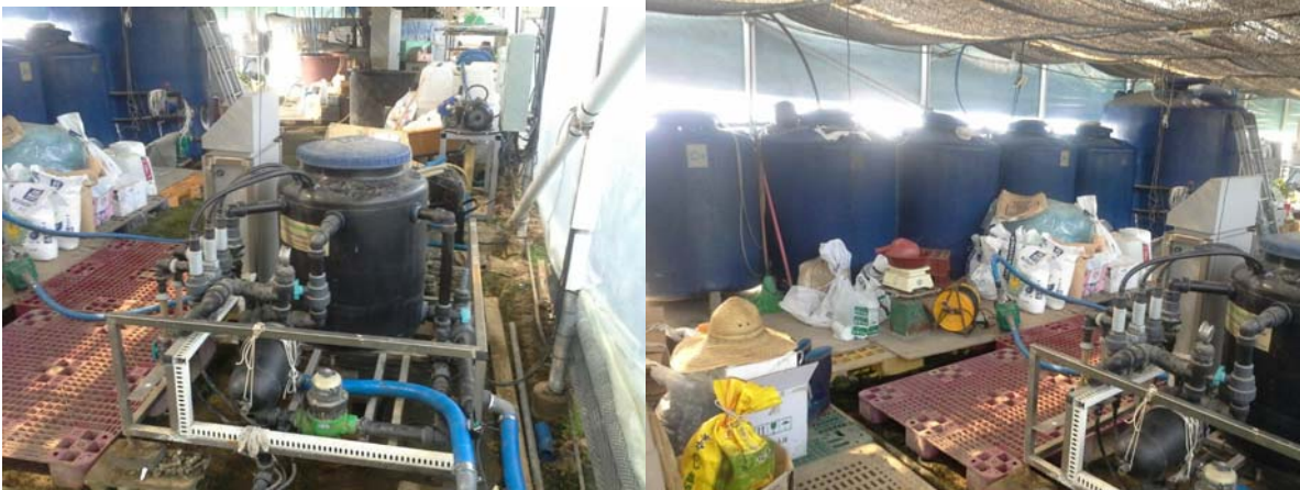
그림 1-5. 비싸고 소음이 강한 외부 콤프레셔와 오염된 물탱크
