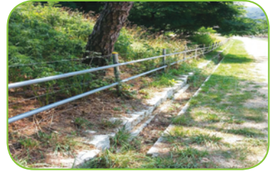
| 초지 내 도로의 배수로 |
