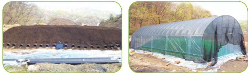
| 연통풍식에 비닐하우스를 설치 장면 |
