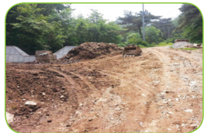
| 시공 중 사방댐 |
