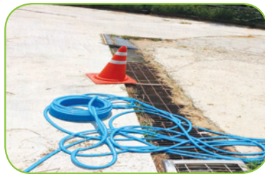
| 급경사 진입도로 하부의 배수로 |
