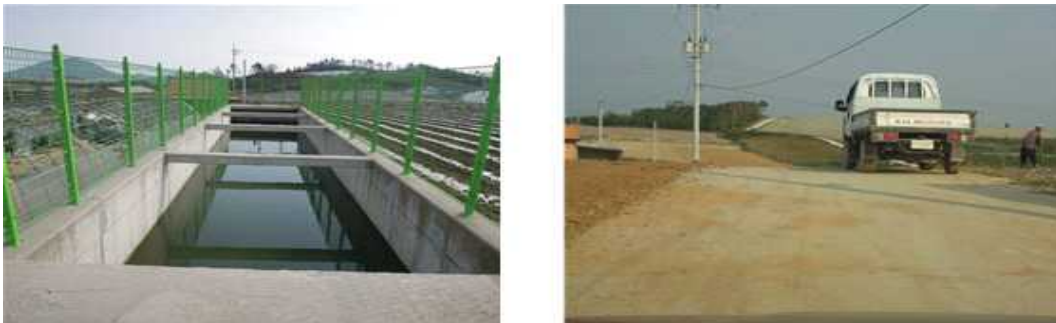
그림 4-7. 지하 저수조 설치 및 대형 농기계 이동을 위한 농로 정비
