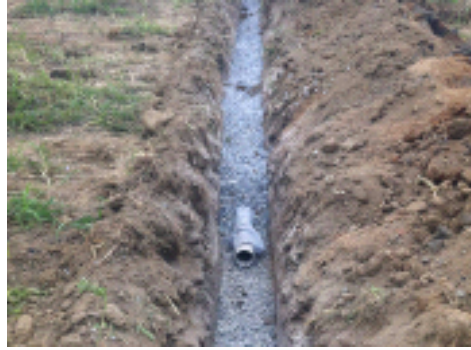
[그림 4.27] 터파기 후 자재 포설
