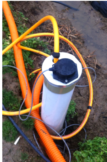
[그림 2.20] 전극봉 설치
