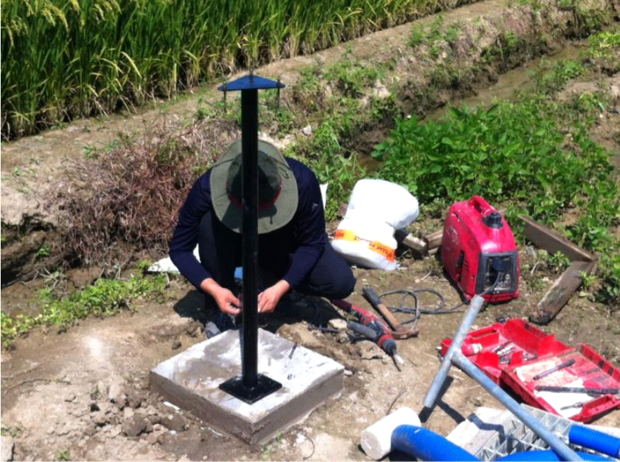
[그림 3.9] 강우량계 기초 및 지주대 설치
