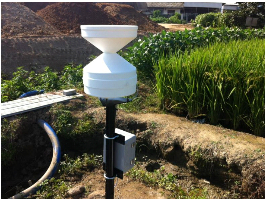
[그림 3.12] 강우량계 Data logger 함체 설치
