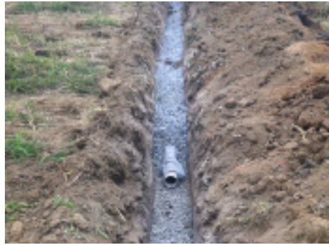
[그림 2.3] 터파기 후 자재 포설
